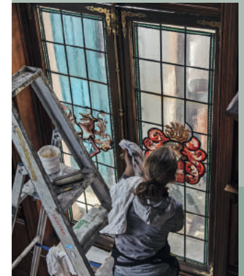
Restauration des vitraux de la Maison des Arts, Schaerbeek. Restauratie van de glas-in-loodramen van het Maison des Arts, Schaerbeek.
