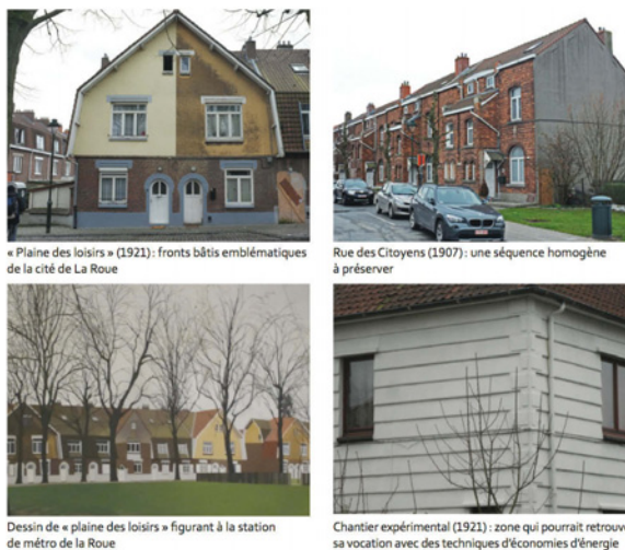
Fig. 12 La cité-jardin de la Roue à Anderlecht. Les séquences historiques les plus anciennes (1907) encore préservées appellent une conservation des façades en l'état. La « plaine des loisirs », qui a fait l'objet de modifications vernaculaires (polychromies des enduits, etc.), possède une dimension symbolique particulière. Les futures solutions de réhabilitation devront prendre en compte ce type de patrimoine. Des études sont à mener pour qualifier les évolutions possibles (réalisé avec Brussels Urbis © CIRB. Photos de l'auteur).
