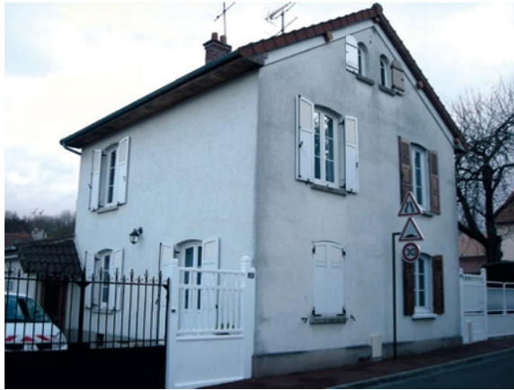
Fig. 1 Maison bi-famille à Noisiel (France). Début XX e siècle. La façade à rue est orientée à l'ouest (© Cerema).
