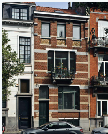
Fig. 3 Avenue Ducpétiaux 47 à Saint-Gilles. Maison individuelle, rénovée en basse énergie. La façade a été maintenue. Elle est isolée par l'intérieur sur les parties intérieures non classées, cela concerne trois des quatre étages. Les propriétaires ont opté pour la pose d'une deuxième fenêtre en retrait de la première afin de conserver la situation initiale (A. de Ville de Goyet, 2015 © SPRB).
