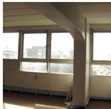
Afb. 11 Living. De hoogte vanaf de afgewerkte vloer tot aan de onderkant van de welfsels bedraagt juist 2,5 m. De opgemeten hoogte tussen de onderkant van de portieken en de afgewerkte vloer is 2 m (© Origin).
