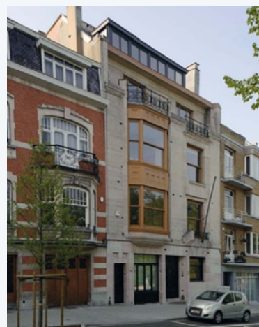
Fig. 2 Avenue Besme 107-109 à Forest. Logements et bureaux. Bâtiment de style Art Déco dont la performance est basse énergie. Les châssis de façade avant ont été conservés et rénovés avec remplacement du simple vitrage par du double vitrage 1.1 (A. de Ville de Goyet, 2015 © SPRB).
