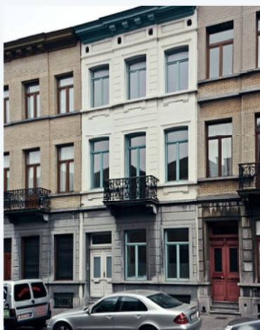
Fig. 1 Rue Rubens 92 à Schaerbeek. Habitation unifamiliale, basse énergie, 39 kWh/m 2 /an. La façade avant a été conservée et les menuiseries, bien qu'à triple vitrage, reproduisent à l'identique la situation initiale. La façade avant a été isolée par l'intérieur et, par respect du patrimoine, certaines bandes ont été laissées sans isolation (A. de Ville de Goyet, 2015 © SPRB).
