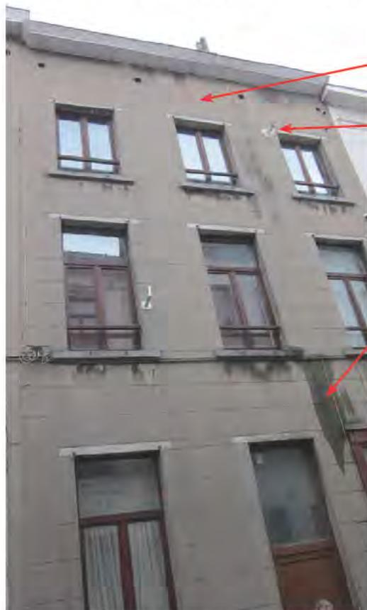
Enduit ciment inapproprié à la structure en briques
