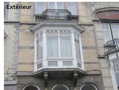
Porte fenêtrée installée comme coupure thermique vis-à-vis de la paroi froide de la bretèche
