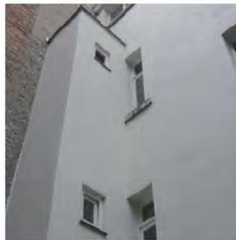
Pont thermique géométrique créé par l'ajout de sanitaires au droit des demis-paliers
