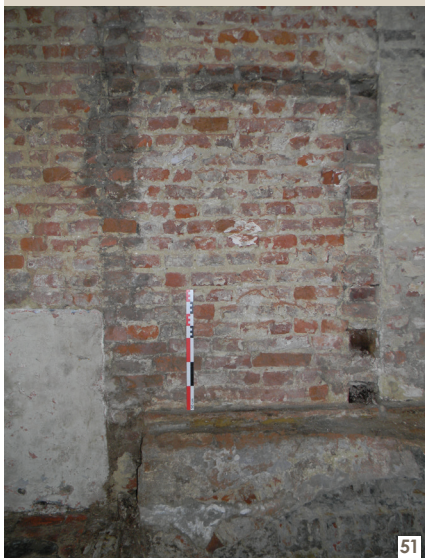
50 Escalier d'accès à la cave ( F 040 ) de la maison 15D, photo : V. Moulaert. © BUP-DMS
