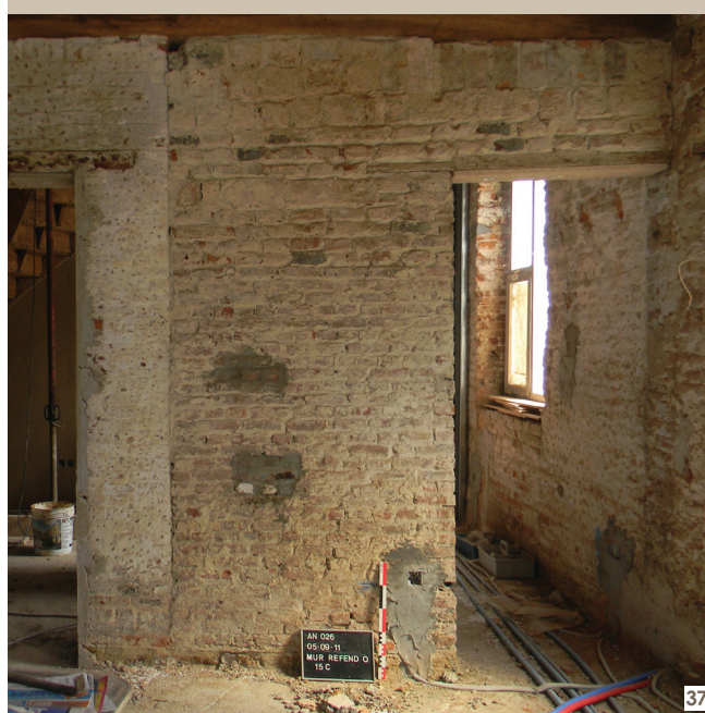
36 Le mur F 002 et les deux portes-fenêtres, photo : V. Moulart. © BUP-DMS
