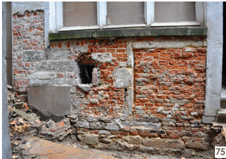
75 De voorgevel van woning B met de kalkzandstenen omlijsting van deuropening (34), foto: B. Claes. © urban. brussels
