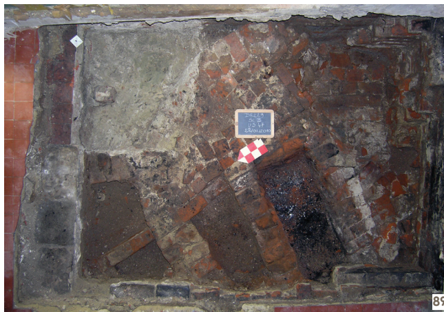
87: Baksteenformaat: 20 x 9 x 5 cm. Voeg: beige kalkmortel. Op de meeste bakstenen zijn sporen merkbaar van de vorm waarin ze vervaardigd werden.
