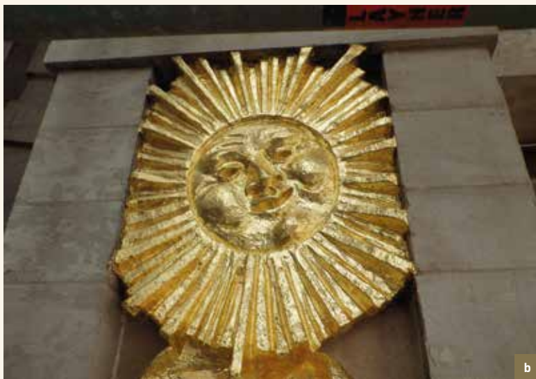
La Louve. Détail de l'ornementation d'un trumeau avec représentation du soleil. a) après nettoyage ; b) après pose de la dorure (© CPH, 2014-2015).
