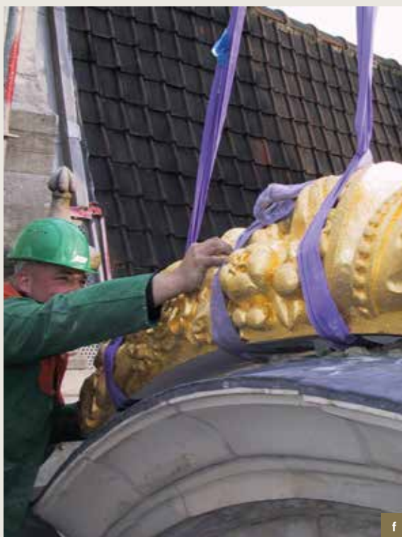
L'Âne . Étapes de remplacement des cornes d'abondance du pignon. a) état des cornes d'abondance en pierre d'Euville avant démontage ; b) sur base d'anciens clichés, les cornes d'abondance fortement endommagées font l'objet de réparations en atelier, au moyen de plâtre. Ces pièces serviront de modèle aux nouveaux éléments ; c) nouvel élément en pierre d'Euville, en cours de réalisation, au moyen de la méthode de mise-aux-points ; d) l'un des éléments terminé ; e) une des sculptures dorée à la feuille d'or ; f) une fois terminées, les cornes d'abondance du pignon sont remontées à l'aide d'une grue, et soigneusement remises en place (© CPH, 2003-2004).
