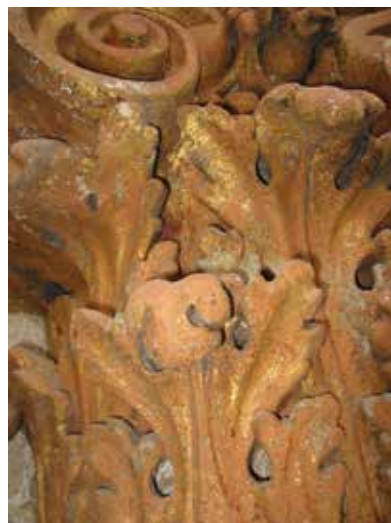
La Maison des Brasseurs. Détail d'un chapiteau composite, après nettoyage et avant restauration (© CPH, 2008).
