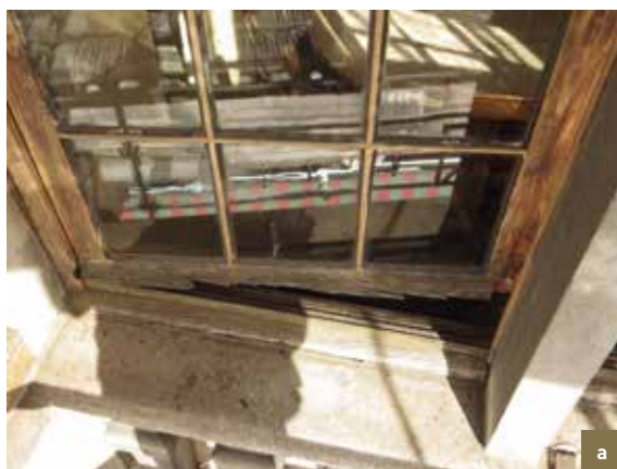
La Rose. Pièces en bois de chêne dégradées. a) un rejet d'eau (pièce inférieure du châssis) à remplacer; b) une pièce d'appui à remplacer (© CPH, 2014).
