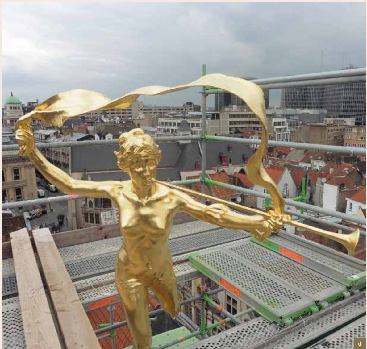
Le Roi d'Espagne . Étapes de la restauration de la statue en bronze de La Renommée (ou La Fortune , Paul Du Bois, 1902). a) La Renommée après restauration ; b) détail de la tête de la statue avant nettoyage ; c) statue en cours de peinture (couches préparatoires à la dorure) ; d) statue dorée (© CPH, 2014-2015).
