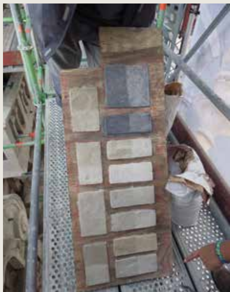
Échantillons de mortier de ragréage exécutés afin de les confronter aux pierres à réparer et de réaliser des choix de texture, granulométrie, et couleur. Cette palette d'échantillons est en permanence sur le chantier (© CPH, 2014).
