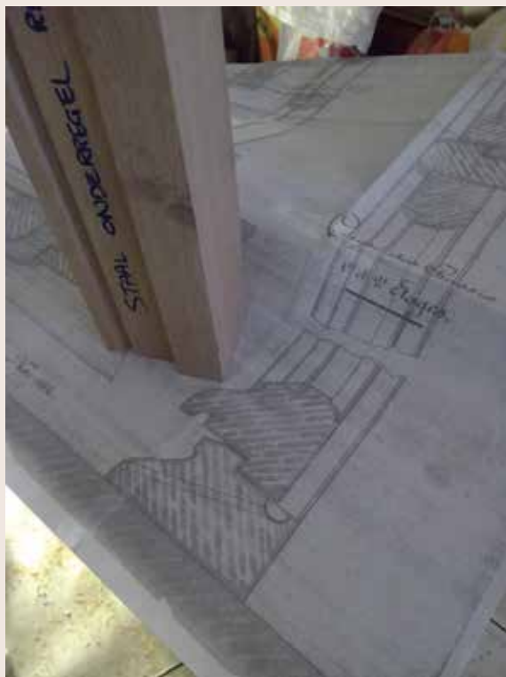
Le Paon. Les dessins d'archives en grandeur réelle ont permis de rétablir les profilés de manière précise (© CPH, 2015).
