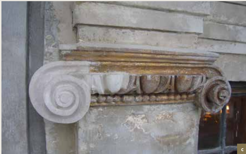
La Rose. Premier étage, volute d'un chapiteau en cours de restauration: a) intégration d'un greffon en pierre de Massangis; b) sculpture en cours d'exécution; c) élément terminé (© CPH, 2008).
