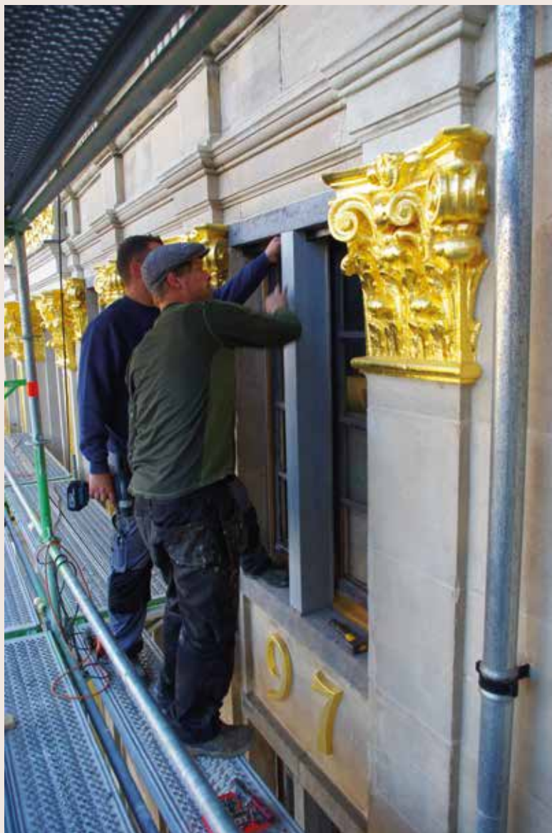
L'Ange. Installation des faux meneaux en bois peint en imitation de pierre bleue. Ceux-ci sont démontables en vue des déménagements (© CPH, 2008).
