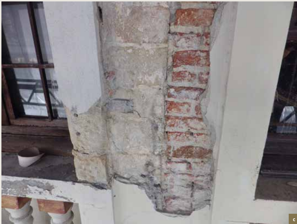
Enduisage de certaines façades. a) La Rose . Essai d'enduisage ; b) Le Petit Renard et Le Chêne . Travail en cours ; c) Le Petit Renard et Le Chêne . Dérochage des parties d'enduit non adhérentes (© CPH, 2008 et 2015).
