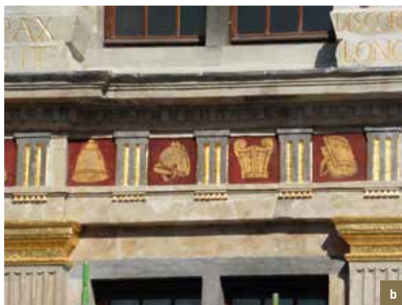
La Louve. Détail des métopes à motifs dorés de la frise faisant allusion aux archers. a) essai de restauration sur la moitié droite; b) résultat final (© CPH, 2014-2015).
