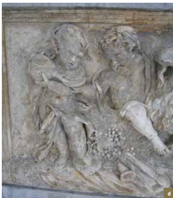
La Maison des Brasseurs . Détails d'un des panneaux d'allège du 2 e étage représentant la vendange (Pierre Van Dievoet, 1698). Probablement en pierre d'Avesnes. a) état encrassé des putti sculptés avant restauration, avec nettoyage partiel à gauche ; b) application de compresses composées d'une pâte de cellulose à base d'ammoniac, destinées à ramollir les croûtes noires ; c) peaufinage du nettoyage à l'aide de la micro sableuse ; d) état après nettoyage (© CPH, 2004).
