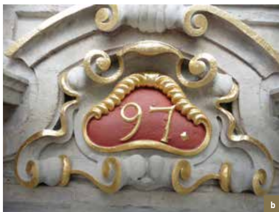
La Brouette. Détail de médaillons avec millésime. a) médaillon de gauche avant restauration; b) médaillon de droite après restauration (réparation des pierres, mise en couleur, dorure) (© CPH, 2014-2015).
