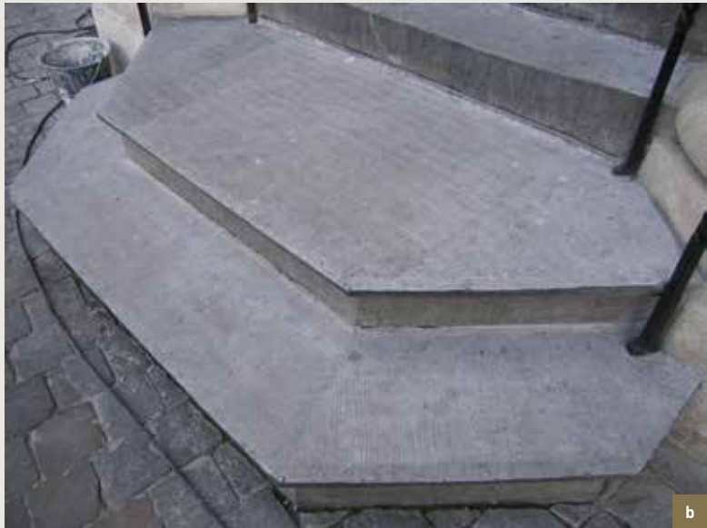
Le Cygne. a) ciselure en cours d'exécution sur les marches d'entrée, selon le modèle existant. Pierre bleue; b) travail terminé (© CPH, 2008).
