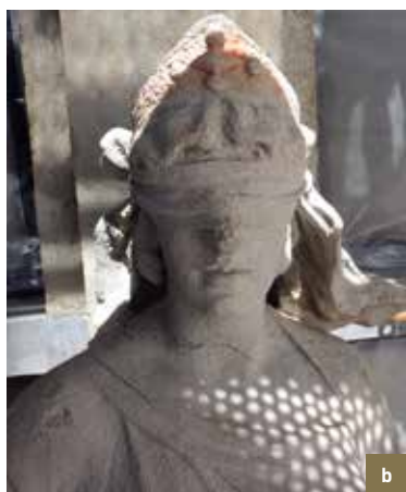
Le Renard . Détail de la statue La Justice (Pierre Comein, 1884). Pierre d'Euville. a) avant nettoyage. Encrassement, fissure périphérique au niveau de la tête ; b) après nettoyage ; c) après restauration de la pierre (fixation de la tête fissurée, ragréage au moyen de mortier selon les photographies des modèles) (© CPH, 2014-2015).
