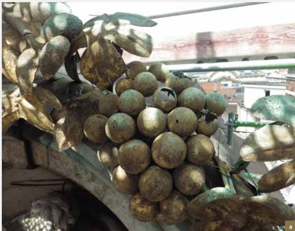
La Brouette. Étapes de la restauration des guirlandes en cuivre. a) état avant restauration (les grappes de raisin sont fortement corrodées, parfois trouées); b, c, d et e) restauration en atelier (avec numérotation), ponçage à la laine de fer, nettoyage à l'eau déminéralisée et à l'acétone, remplissage des lacunes (époxy) et mise en place de la dorure [© CPH, 2014-2015].
