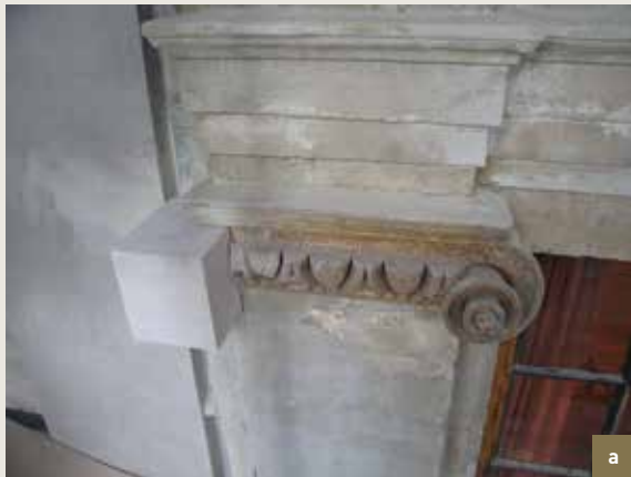
Le Cygne. a) ciselure en cours d'exécution sur les marches d'entrée, selon le modèle existant. Pierre bleue; b) travail terminé (© CPH, 2008).
