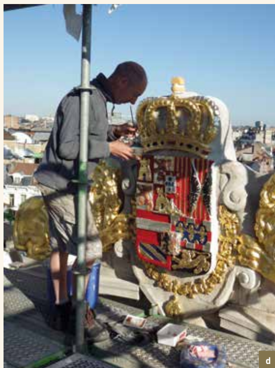
Le Cornet . Étapes de la restauration de l'écusson polychromé sur base d'un document original. a) avant nettoyage ; b) après nettoyage ; c) document d'archives indiquant précisément les pigments de l'écusson ; d) restauration et restitution de la polychromie en cours ; e) l'élément presque achevé. À côté de la polychromie, on peut observer des parties dorées ou en cours de dorure, ainsi que des parties recouvertes de feuilles d'argent, selon les instructions des documents d'origine (© AVB et CPH, 2014-2015).
