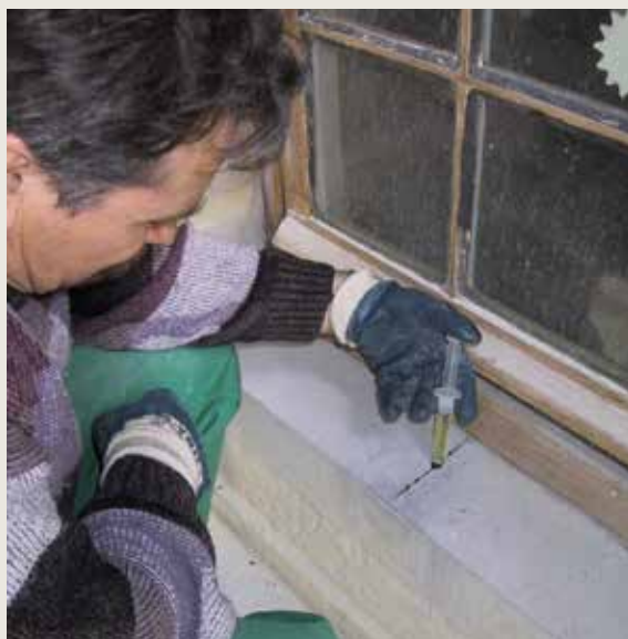
L'Âne . Seuil en pierre bleue. Injection du produit (époxy bi-composant) par les petits trous préparés à cet effet (© CPH, 2003-2004).
