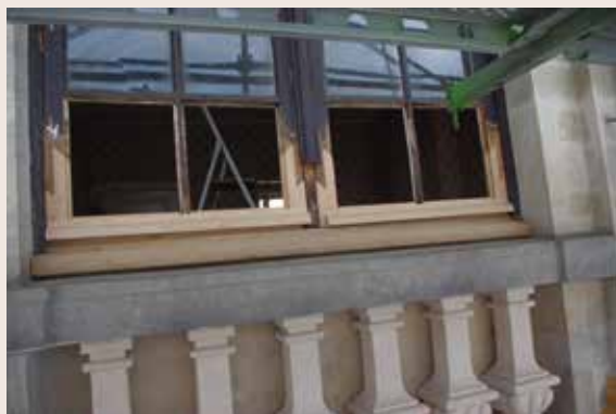
Le Pigeon. Remplacement de la pièce d'appui et des rejets d'eau et placement de greffons. Bois de chêne (© CPH, 2008).
