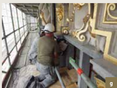
Le Sac. Étapes de restitution d'un chapiteau : a) état dégradé ; b) dépose de l'élément ; c) moulage d'un chapiteau en bon état ; d) moule en silicone et coque en polyester armé de fibres de verre ; e) positif en plâtre ; f) nouvelle sculpture en pierre de Savonnière ; g) intégration de l'élément en pierre [© CPH, 2014-2015].
