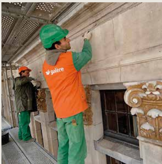
L'Étoile . Rejointoiement au mortier (© Daylight, 2008).
