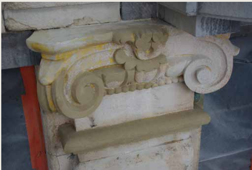
L'Ange. Chapiteau en cours de restauration. Pierre d'Euville (© CPH, 2012).
