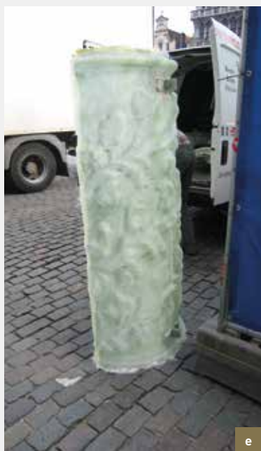
La Maison des Brasseurs. Colonne décorée de feuillage torsadé. a) les parties métalliques ont fait fissurer ou éclater l'élément (cimentage sur pierre originale). État dégradé avant moulage et restauration; b) carottage effectué pour prélever un échantillon du cimentage; c) moulage au moyen de silicone; d) coque en résine de polyester, renforcée de fibres de verre; e) le moulage est transporté en vue d'une restitution éventuelle; f) finalement, les éléments ont été restaurés sur place, peints et dorés à la feuille (© CPH, 2014-2015)
