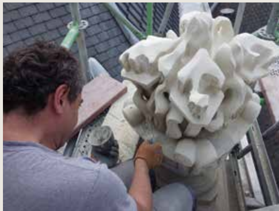
La Louve. Pot à feu du fronton en cours de réparation. Pierre de France (© CPH, 2014).
