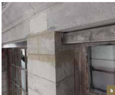
Sainte-Barbe. a) détail de la pierre à remplacer, marquée d'une croix avec une craie rouge ; b) nouveaux éléments en pierre de Gobertange et barres en acier inoxydable (© CPH, 2015).
