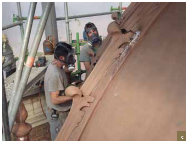
Le Roi d'Espagne . Étapes de la restauration de la coupole en cuivre. a) état de la coupole avant restauration avec encrassement et patine verte; b et c) sablage en cours afin de mettre à nu le cuivre et de le restaurer, notamment pour remplacer des pièces abîmées et refaire des soudures défectueuses; d) nettoyage et polissage réalisés au moyen de laine de fer (© CPH, 2015).
