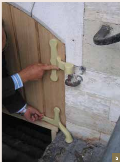
Le Cygne. Restitution des portillons des caves avec leurs ferrures. a) dessin d'archives servant à la fabrication des nouvelles ferrures ; b) portillon en chêne placé. Présentation de la maquette en résine des ferrures pour approbation du modèle (© CPH, 2008 et AVB).
