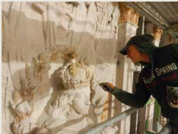
Le Roi d'Espagne. Détail du bas-relief représentant le Trophée de Charles II . Réparation de la couronne en cours. Mortier de ragréage et pierre d'Euville (© CPH, 2014).
