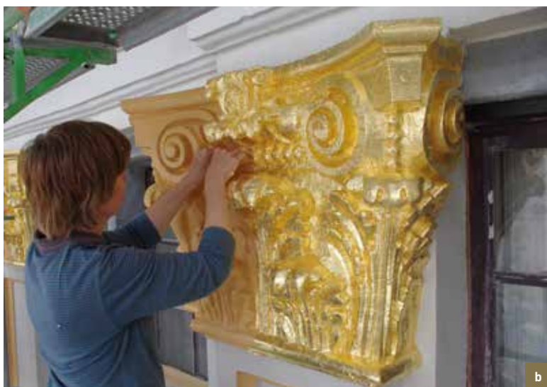
La Chaloupe d'Or. Détail d'un chapiteau. a) vérification du choix de la dorure ; b) à gauche, couche préparatoire jaune orangé ; à droite, mise en place des feuilles d'or sur mixtion (© CPH, 2012).
