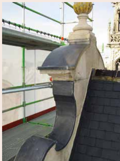
Aux Armes de Brabant. Plomb rétabli sur les parties exposées aux ruissellements de pluie du pignon (© CPH, 2008).
