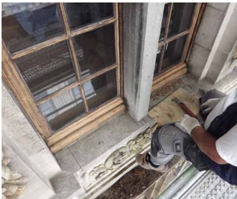
La Brouette. Décapage manuel des châssis. Bois de chêne (© CPH, 2014).
