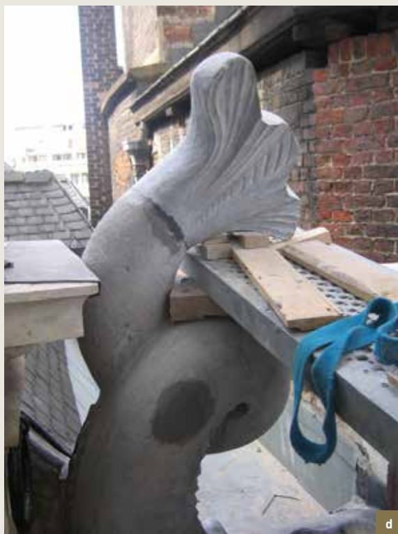
La Maison des Brasseurs . Détail des dauphins en pierre bleue du pignon en pierre bleue. a) à gauche, dauphin en pierre bleue servant de modèle à la partie manquante du dauphin de droite; b) à droite, dauphin avec nageoire caudale manquante; c) moulage de la nageoire caudale du dauphin de gauche et nouvel élément en pierre bleue, destiné à restituer la partie manquante du dauphin de droite. Moulage en résine de polyester armée de fibre de verre et nouvelle sculpture en pierre bleue; d) le nouvel élément en pierre bleue placé sur le dauphin de droite (© CPH, 2008).
