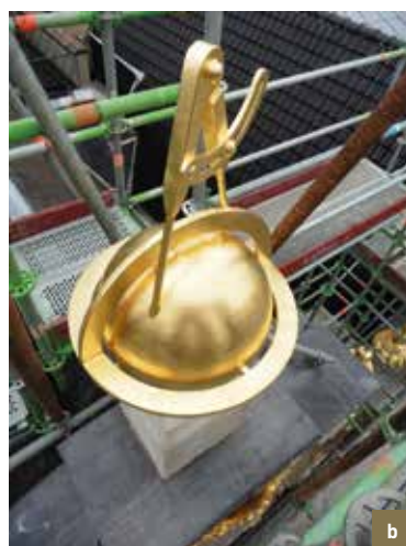
Le Sac. Mappemonde. a) dessin d'archives ayant servi à la fabrication de la nouvelle mappemonde en zinc, suite à la dégradation trop importante de l'existante (© AVB); b) nouvelle mappemonde dorée au sommet du pignon (© CPH, 2014-2015).
