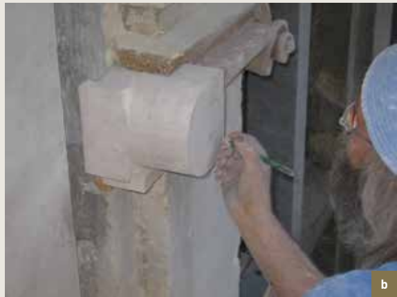
La Rose. Premier étage, volute d'un chapiteau en cours de restauration: a) intégration d'un greffon en pierre de Massangis; b) sculpture en cours d'exécution; c) élément terminé (© CPH, 2008).
