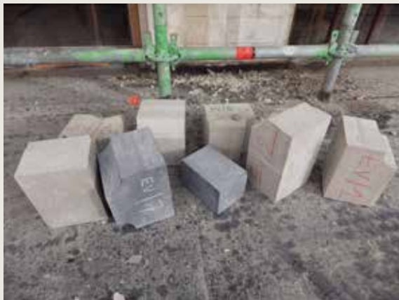
Nouvelles pierres livrées sur chantier pour effectuer les réparations nécessaires suite à l'éclatement des pierres dues à la corrosion des éléments métalliques. Pierre de Gobertange et pierre bleue (© CPH, 2015).
