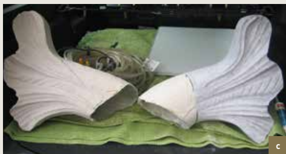
La Maison des Brasseurs . Détail des dauphins en pierre bleue du pignon en pierre bleue. a) à gauche, dauphin en pierre bleue servant de modèle à la partie manquante du dauphin de droite; b) à droite, dauphin avec nageoire caudale manquante; c) moulage de la nageoire caudale du dauphin de gauche et nouvel élément en pierre bleue, destiné à restituer la partie manquante du dauphin de droite. Moulage en résine de polyester armée de fibre de verre et nouvelle sculpture en pierre bleue; d) le nouvel élément en pierre bleue placé sur le dauphin de droite (© CPH, 2008).
