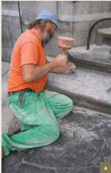
Le Cygne. a) ciselure en cours d'exécution sur les marches d'entrée, selon le modèle existant. Pierre bleue; b) travail terminé (© CPH, 2008).
