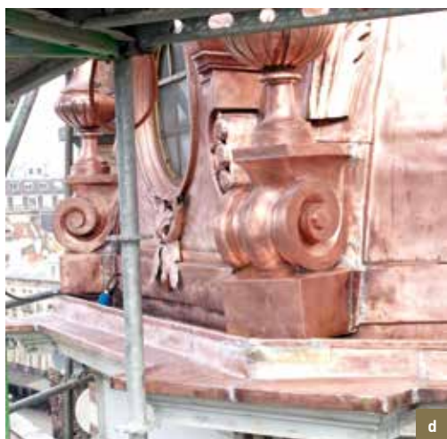
Le Roi d'Espagne . Étapes de la restauration de la coupole en cuivre. a) état de la coupole avant restauration avec encrassement et patine verte; b et c) sablage en cours afin de mettre à nu le cuivre et de le restaurer, notamment pour remplacer des pièces abîmées et refaire des soudures défectueuses; d) nettoyage et polissage réalisés au moyen de laine de fer (© CPH, 2015).
