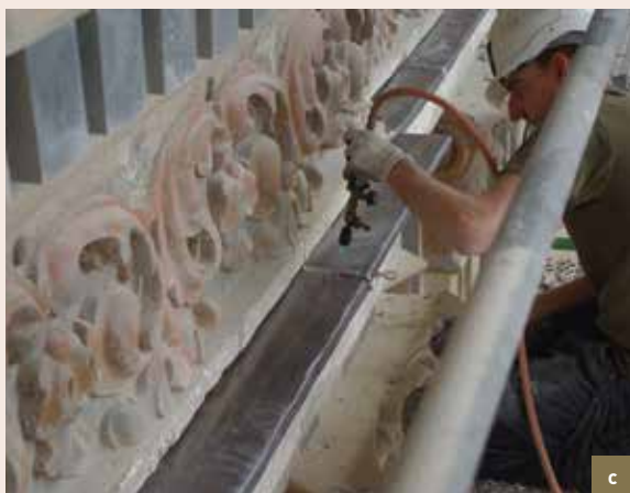
La Chaloupe d'Or. a) page de gauche : vue d'ensemble du fronton restauré, avec les denticules en zinc des entablements et les recouvrements en plomb des parties saillantes (© Utopix, M. Ploton, 2018); b) détail sur les denticules en zinc et sur les recouvrements en plomb en cours d'exécution; c) idem. Soudage en cours (© CPH, 2008).
