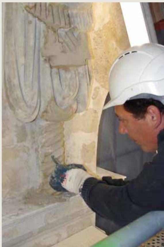
Le Pigeon . Restauration en cours au mortier de ragréage (élément torsadé du mascarón). Pierre indéterminée (© CPH, 2012).
