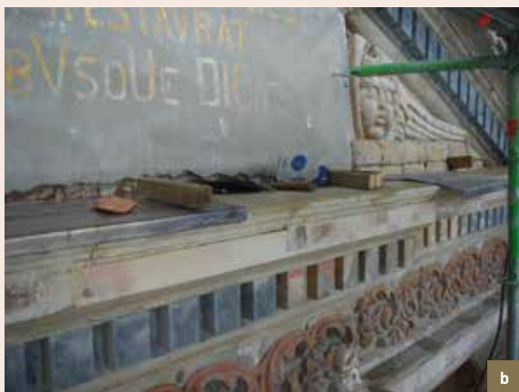
L'Étoile. Corniche en zinc en cours de renouvellement (© CPH, 2008).
