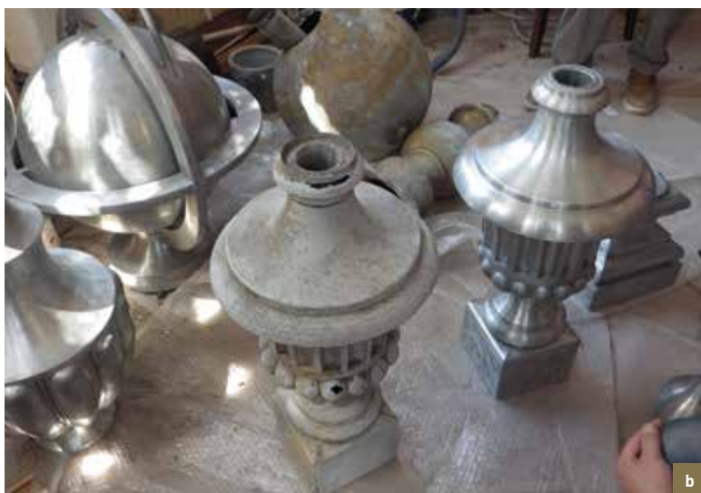
Le Sac. Vases en zinc. a) élément original fissuré et troué; b) anciens et nouveaux éléments (© CPH, 2014-2015).
