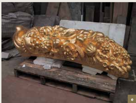
L'Âne . Étapes de remplacement des cornes d'abondance du pignon. a) état des cornes d'abondance en pierre d'Euville avant démontage ; b) sur base d'anciens clichés, les cornes d'abondance fortement endommagées font l'objet de réparations en atelier, au moyen de plâtre. Ces pièces serviront de modèle aux nouveaux éléments ; c) nouvel élément en pierre d'Euville, en cours de réalisation, au moyen de la méthode de mise-aux-points ; d) l'un des éléments terminé ; e) une des sculptures dorée à la feuille d'or ; f) une fois terminées, les cornes d'abondance du pignon sont remontées à l'aide d'une grue, et soigneusement remises en place (© CPH, 2003-2004).
