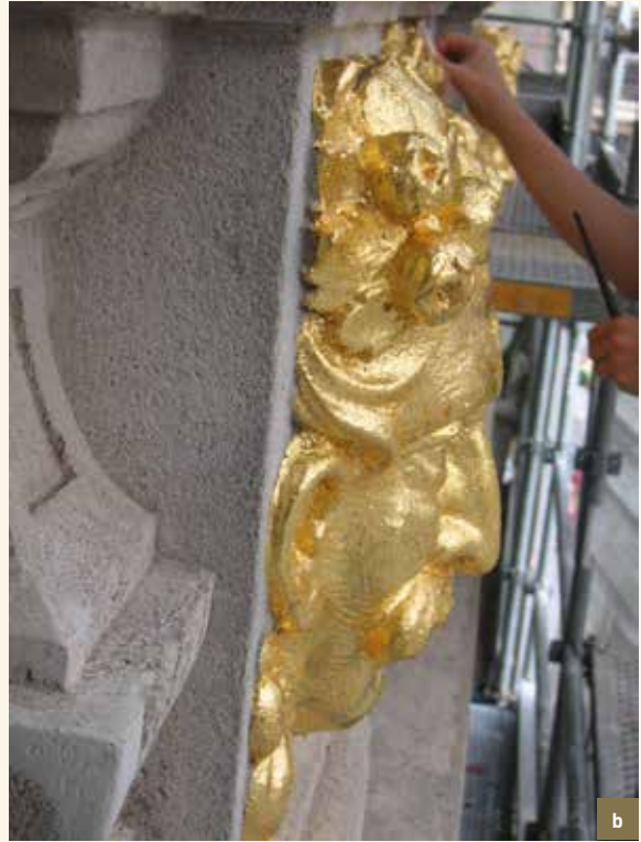
La Maison du Cygne . a et b) les mascarons du balcon en cours de dorure (Venneman, 1903). Euville (© CPH, 2008).
