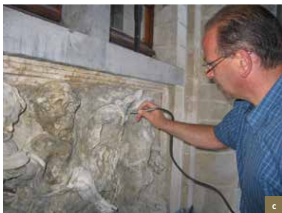
La Maison des Brasseurs . Détails d'un des panneaux d'allège du 2 e étage représentant la vendange (Pierre Van Dievoet, 1698). Probablement en pierre d'Avesnes. a) état encrassé des putti sculptés avant restauration, avec nettoyage partiel à gauche ; b) application de compresses composées d'une pâte de cellulose à base d'ammoniac, destinées à ramollir les croûtes noires ; c) peaufinage du nettoyage à l'aide de la micro sableuse ; d) état après nettoyage (© CPH, 2004).
