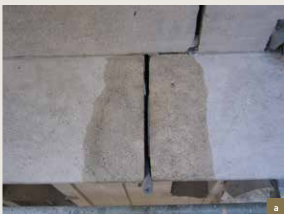
L'Étoile . a et b) injection d'un coulis de mortier (© CPH, 2008).
