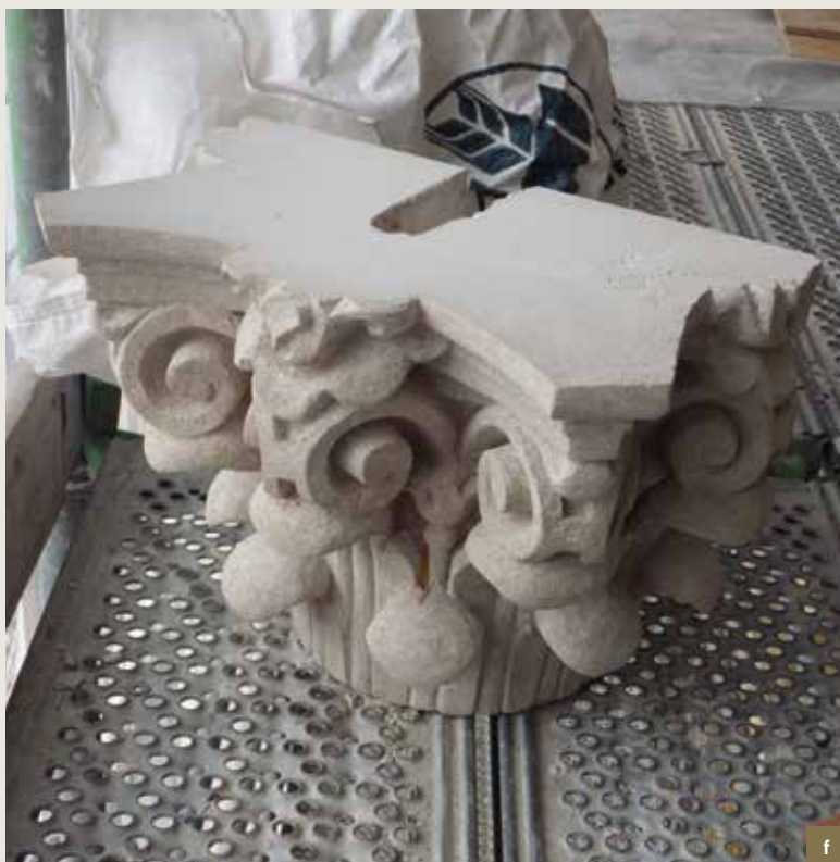
Le Sac. Étapes de restitution d'un chapiteau : a) état dégradé ; b) dépose de l'élément ; c) moulage d'un chapiteau en bon état ; d) moule en silicone et coque en polyester armé de fibres de verre ; e) positif en plâtre ; f) nouvelle sculpture en pierre de Savonnière ; g) intégration de l'élément en pierre [© CPH, 2014-2015].
