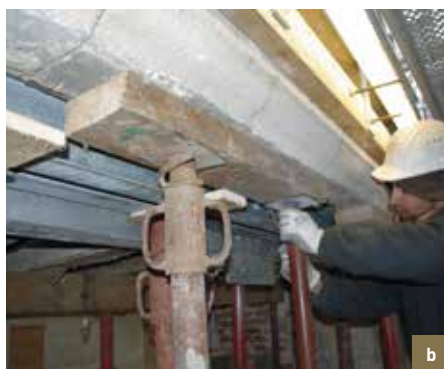
Le Cerf. a) étaisonnement des maçonneries en Euville et pose de carcan métallique en vue de démonter les poutrelles métalliques corrodées ; b) placement de nouvelles poutrelles en acier galvanisé (© CPH, 2008).
