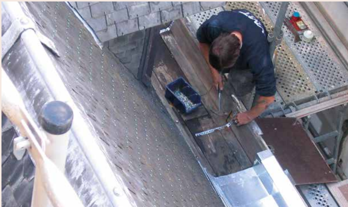
L'Étoile. Corniche en zinc en cours de renouvellement (© CPH, 2008).
