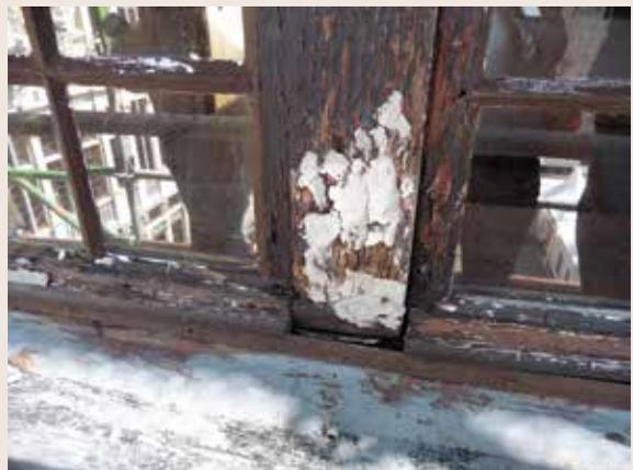
*Le Petit Renard et le Chêne/Het Vosken en Den Eycke.* Badly damaged window frame (© HHU, 2014).
