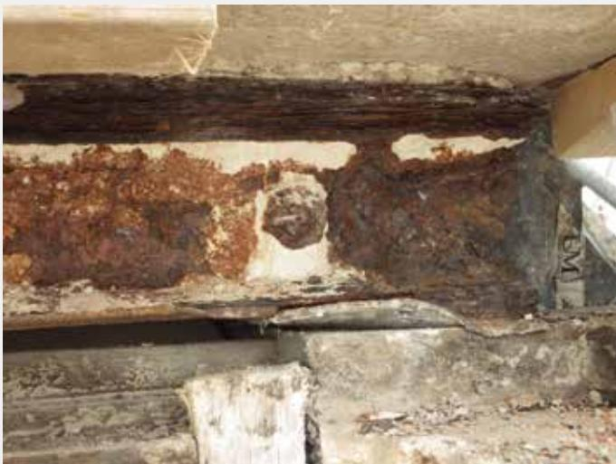
*Le Petit Renard et Le Chêne/Het Vosken en Den Eycke.* Corrosion and development of rust on a metal beam (© HHU, 2014).
