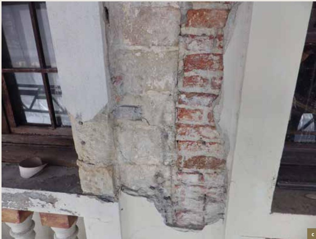
Coating of certain façades. a) *La Rose/De Roose*. Test coating; b) *Le Petit Renard et le Chêne/Het Vosken en Den Eycke*. Work in progress; c) *Le Petit Renard et le Chêne/Het Vosken en Den Eycke*. Removal of loose sections of render (© HHU, 2008 and 2015).
