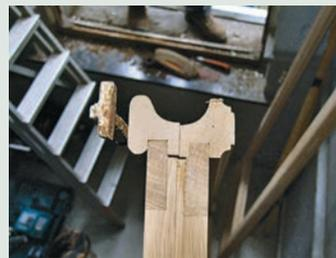
Remplacement d'un ouvrant en façade arrière. Détail de la gueule de loup, vue par en-dessous.
