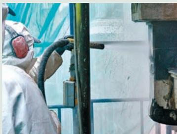
Nettoyage de la pierre d'Euville: sablage hydropneumatique ponctuel en complément du nettoyage à la vapeur.
