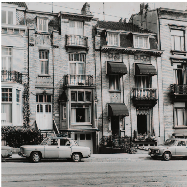
Fig. 7a Maisons particulières, avenue Brugmann 408-410 à Uccle, 1907 (gauche) et 1906 (droite), (© AAM).
