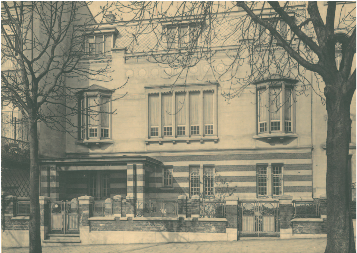
Fig. 5a Hôtel de maître, avenue Brugmann 523 à Uccle, 1908, démoli [ L'Émulation , 1914, pl. XXII, © CDBDU].
