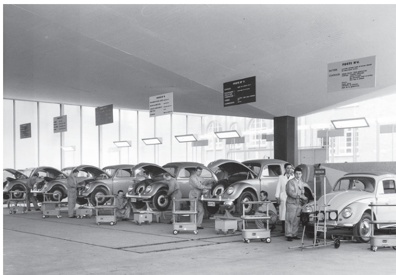
Fig. 2 Ateliers du garage d'Ieteren-Volkswagen au Heysel, 1958 (arch. Claude Laurens, ing. Hoite Cornelis Duyster et entrepreneur Strabed) (© Archives Laurens, Paris).
