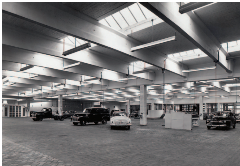
Fig. 1 Ateliers du garage Wismeyer à Uccle, 1949 (arch. Charles Malcause et Robert Puttemans, entrepreneur & ingénieur Blaton-Aubert) (© AAM, Fonds Blaton).
