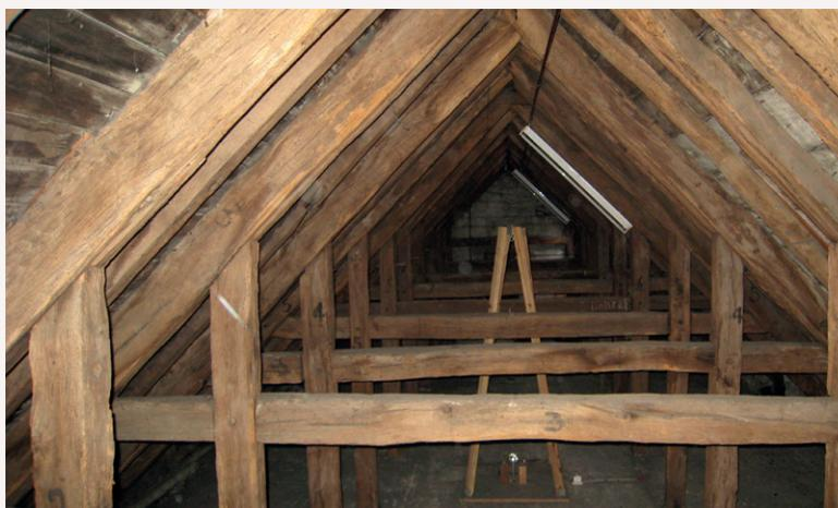
(fig. 5) expliquant ainsi le constat de la présence d'une seule ferme de charpente soutenant la toiture très pentue et imposante (fig. 6). Une étude dendrochronologique et radiocarbone, décidée sur base de ces constatations, a livré une datation entre 1445 et 1485 venant confirmer le haut potentiel de cet îlot et la présence dans le bâti du XIX<sup>e</sup> siècle d'un noyau ancien de la fin du Moyen Âge que l'on peut rattacher à l'hospice Saint-Ghislain<sup>12</sup>.
