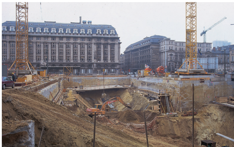
Fig. 17 La place Poelaert au milieu des années 1990. Travaux pour la création du parking souterrain (© SPRB).
