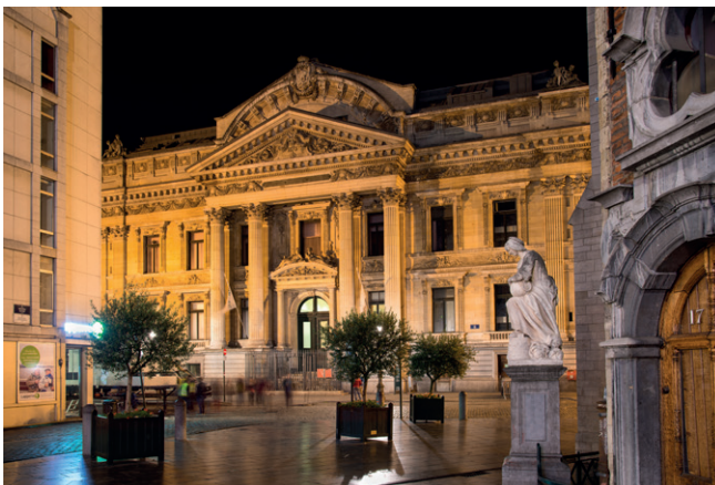
Geert MOYAERT | Palais de la Bourse, Bruxelles
