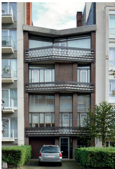
Maison Rombaut-Deplus (2014 © SPRB).
