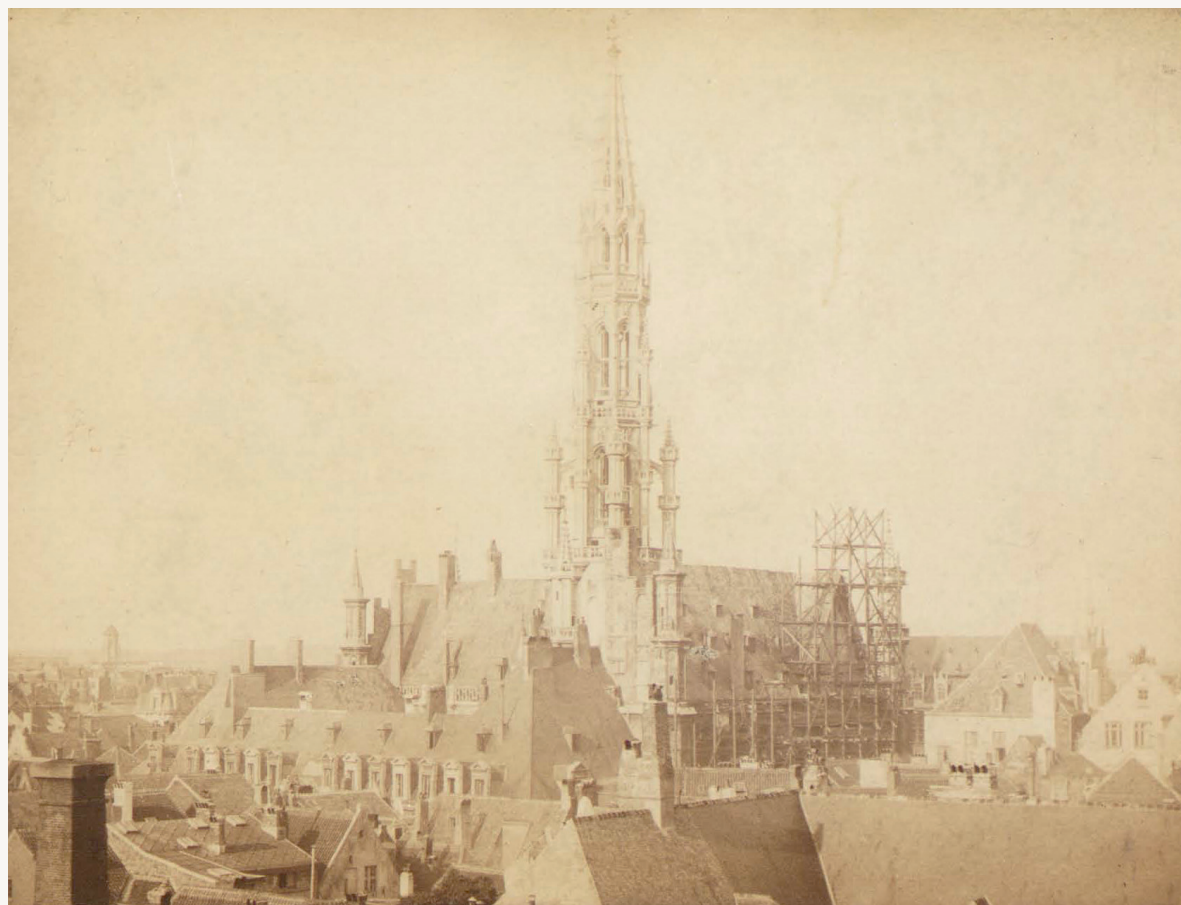
Hôtel de ville de Bruxelles. Reconstruction de la façade, côté de l'actuelle rue Charles Buls, photographiée en 1893 (© AVB).
