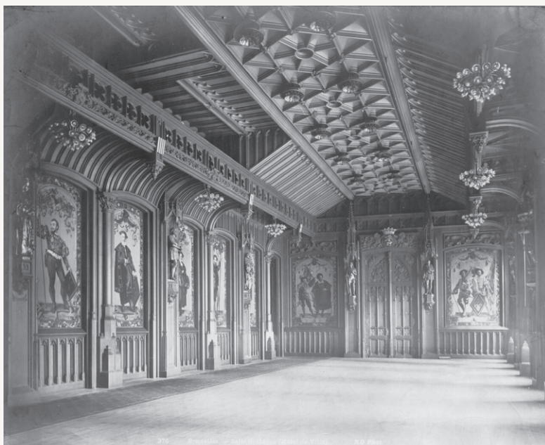
Fig. 3 La salle gothique dans son état entre 1880 et 1895 (© AVB).
