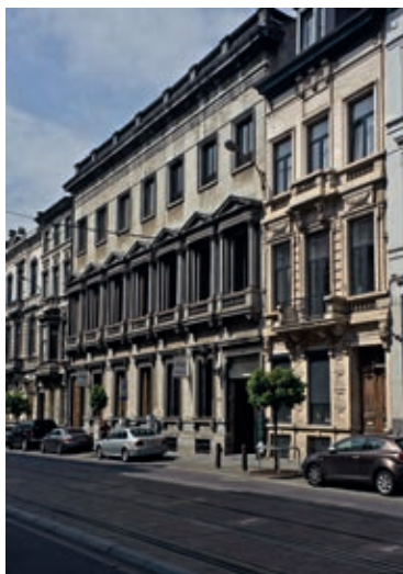
Fig. 13 Rue Royale 286-298, Saint-Josse-ten-Noode. Enfilade des immeubles sur l'ancienne parcelle du pavillon Cazeaux (A. de Ville de Goyet, 2016 © SPRB).
