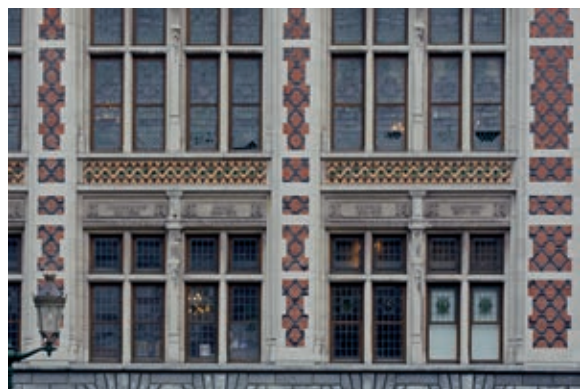
Fig. 6b Hôtel communal de Schaerbeek, façade actuelle, détail (© SPRB).
