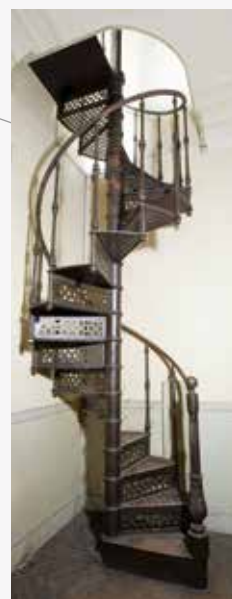
Fig. 25c Escalier en colimaçon (© KIK-IRPA, Bruxelles).
