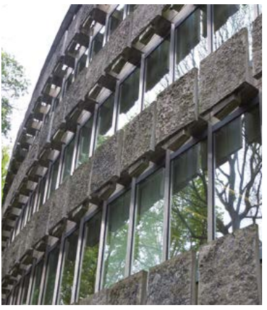
Fig. 9 Détail de la texture des éléments de pierre fournis à partir des croûtes brutes entre lits de pierre extraite (photo H. Lionnez).
