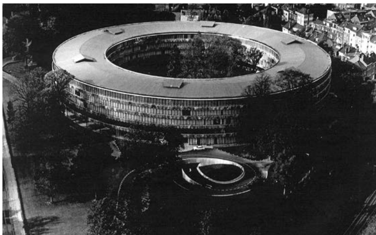
Fig. 3 Bâtiment Glaverbel. Photo aérienne à l'époque de sa réalisation (archives des Ateliers de Genval).
