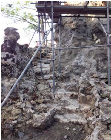
Fig. 4 L'escalier réapparu après déblaiement des terres, jusqu'à 1 m de profondeur (photo de l'auteur).
