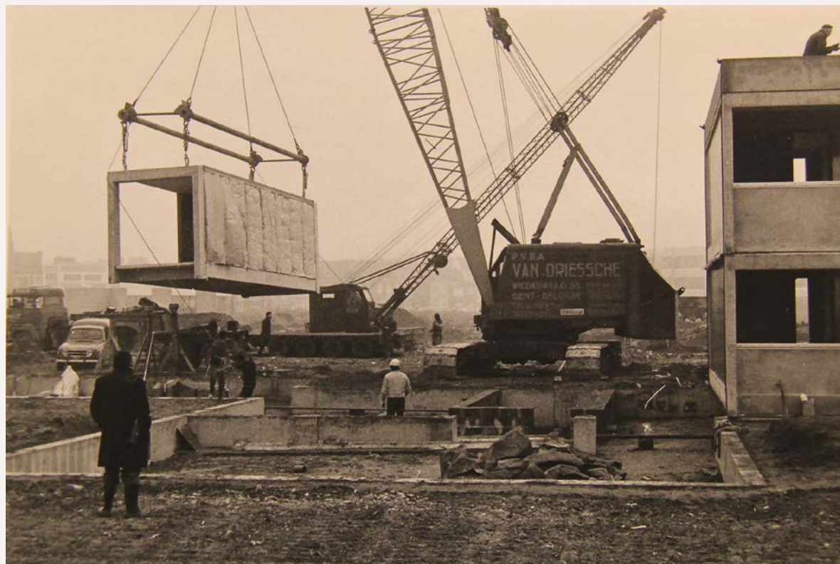
Fig. 3 Placement des modules Variel pour le village étudiant de la VUB, début 1973 (© Archives Service Infrastructure, VUB, Bruxelles).
