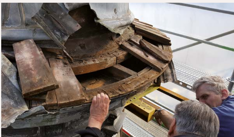
Démontage de la couverture en plomb (© SPRB).
