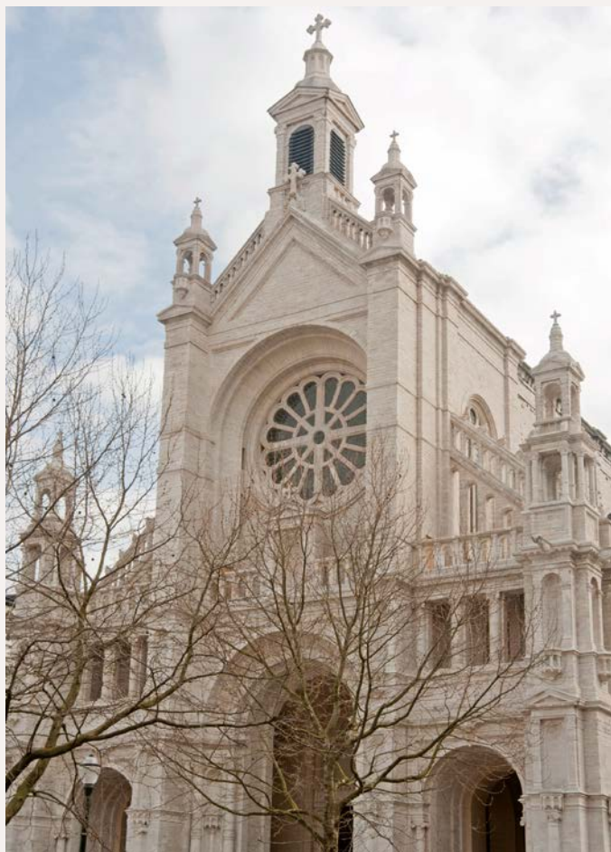
Façade de l'église Sainte-Catherine après restauration en 2013 (A. de Ville de Goyet © SPRB).
