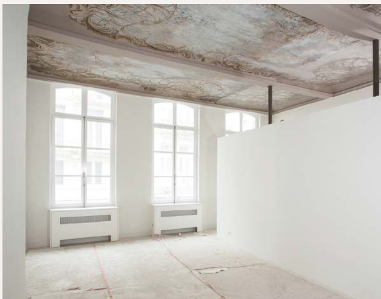
Vue du plafond après sa restauration. Le corps de la cheminée, à gauche, qui avait disparu a été reconstitué. La zone éclairée par les deux fenêtres de gauche accueille le salon de l'appartement ; l'espace à droite, derrière la cloison, sert de chambre à coucher. La partie plus claire du plafond, à droite, était celle surpeinte qui a été retouchée au tratteggio . (© KIK-IRPA, Bruxelles).
