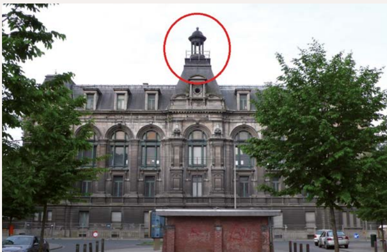
Façade côté, rue avant la dépose de la lanterne (© SPRB).
