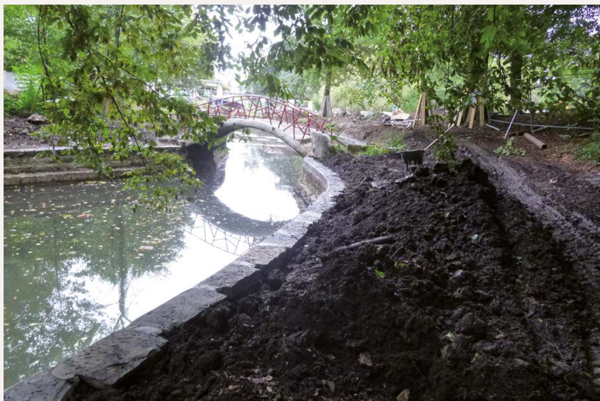
Réfection des berges des pièces d'eau du parc Marie-José (É. Stoller © SPRB).
