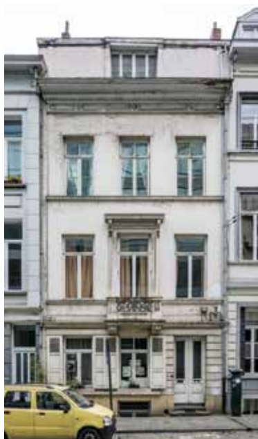
Fig. 1 Façade avant de la Maison Hastir (© KIK-IRPA, Bruxelles_BUP/BSE, 2016).
