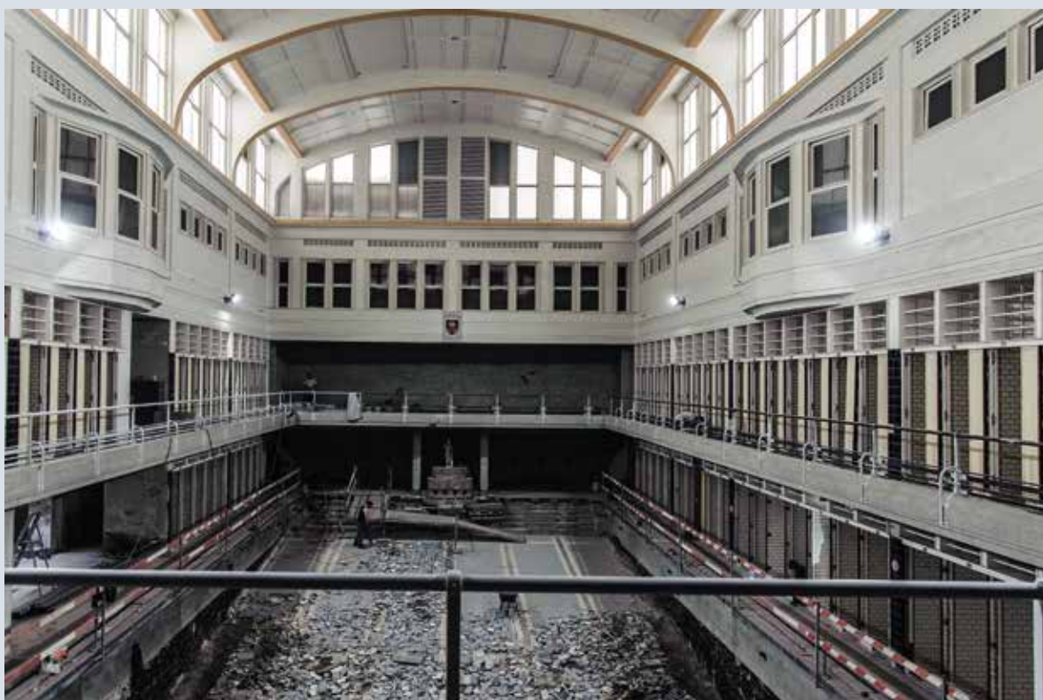
▼ Les Bains de Saint-Josse, une piscine Art Déco en chantier, rue Saint-François 23-27 à Saint-Josse-ten-Noode (A. de Ville de Goyet, 2018 © BUP/BSE).
