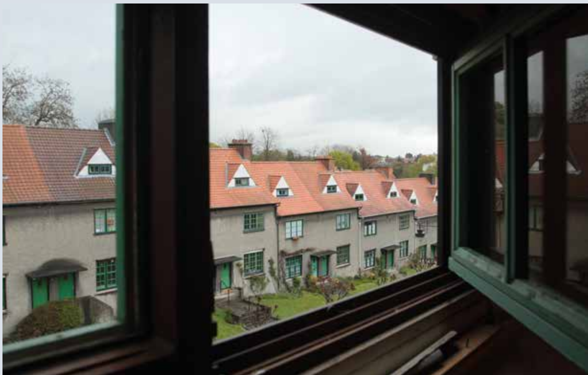
▲ Le Logis à Watermael-Boitsfort, une première expérience collective portant sur la restauration et la rénovation de plus de 300 habitations (P.-P. Hoffman, 2018 © BUP/BSE).
