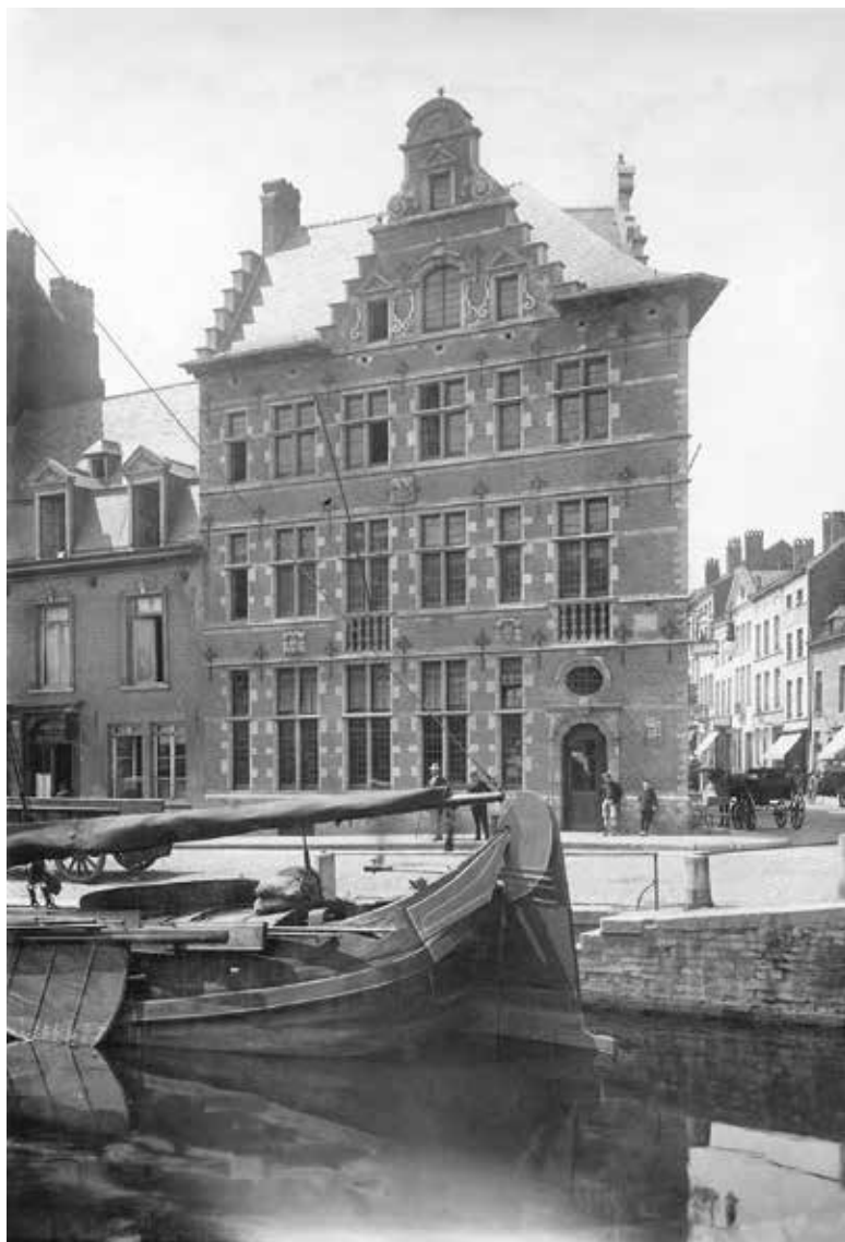
Fig. 2 Maison « Au Cheval Marin », extérieur (© KIK-IRPA, Bruxelles, 1900, cliché 3527A).
