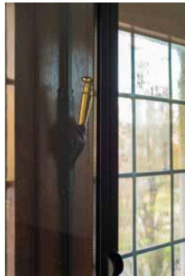
Fig. 5 Vue intérieure, châssis métalliques (photo de l'auteur, 2017).
