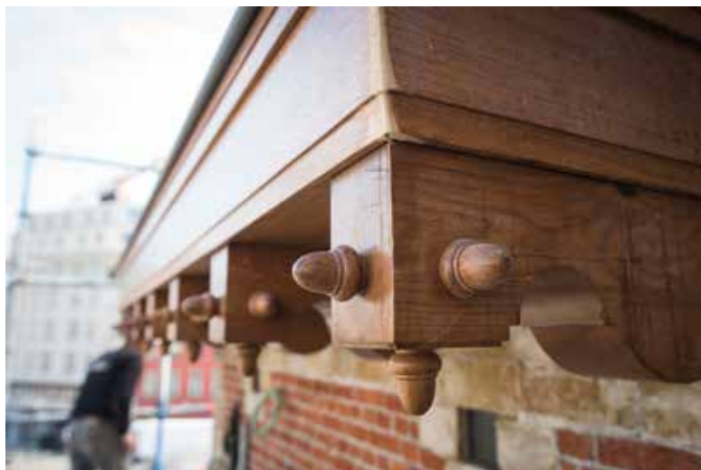
Fig. 6 Vue de la corniche à corbeaux décorés (photo de l'auteur, 2017).
