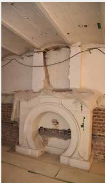
Fig. 4 Cheminée de l'ancienne salle à manger, rez-de-jardin (photo O. Berckmans, février 2017).
