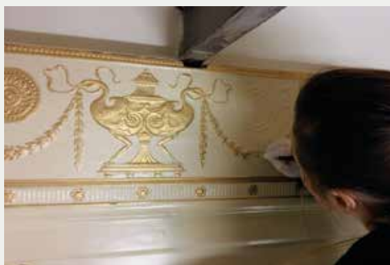
Fig. 10 Restauration et dorure sur frise en carton pierre (© Ma 2 , septembre 2018).
