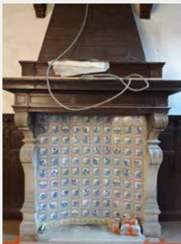
Fig. 8 Cheminée du salon néo-Renaissance flamande après restauration (© Ma 2 , août 2018).
