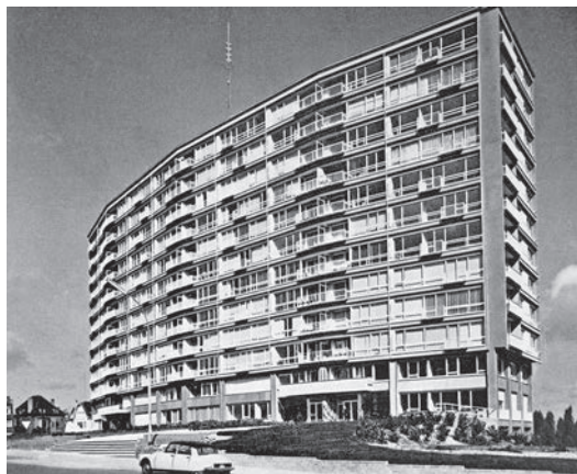
Fig. 25. La tour Europa I, boulevard Léopold III, Schaerbeek, en 1966 (Architecture, 70, 1966, p. 345).
