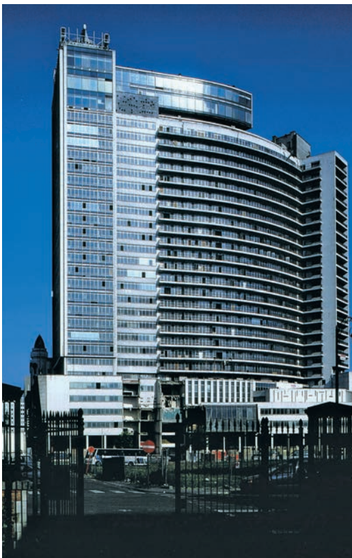
Fig. 22 La tour Rogier (démolie) (© Chr. Bastin & J. Evrard © MRBC).
