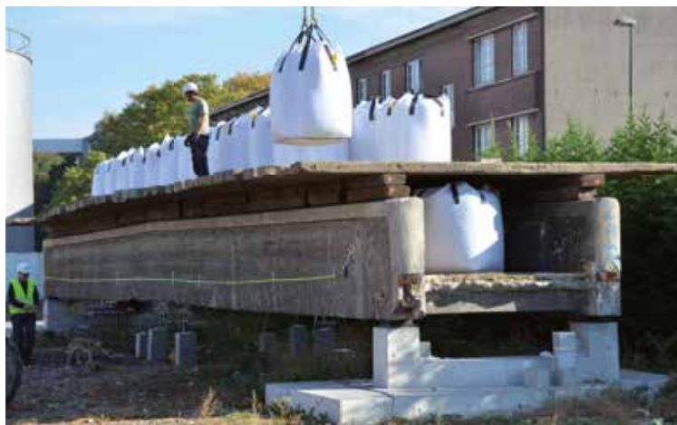
Fig. 8 Chargement de la passerelle au moyen de sacs de granulats (photo des auteurs).
