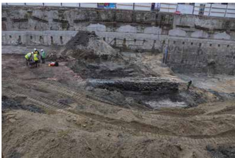
Tronçon du mur de quai, avril 2019 (© Urban.brussels).
