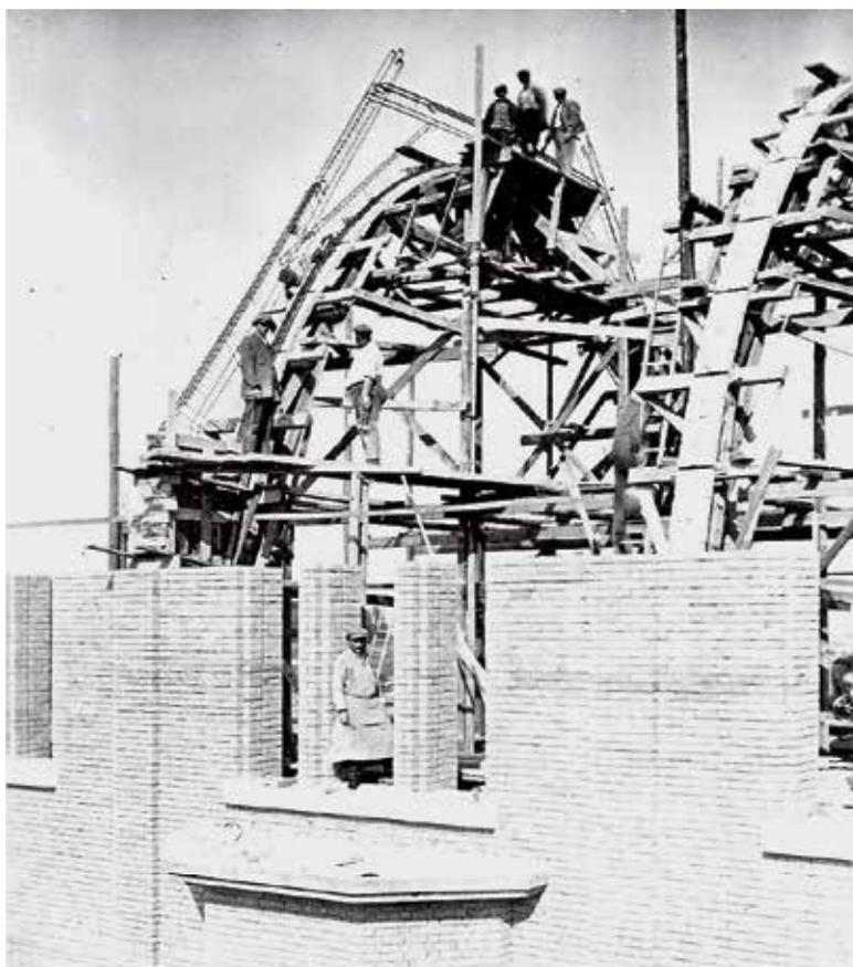
**Fig. 13** Construction de l'église du Divin Sauveur à Schaerbeek (1935) : les ouvriers prennent la pose alors qu'ils sont occupés à mettre en place les armatures de la première ferme de la charpente (© Archives de la fabrique d'église du Divin Sauveur).
