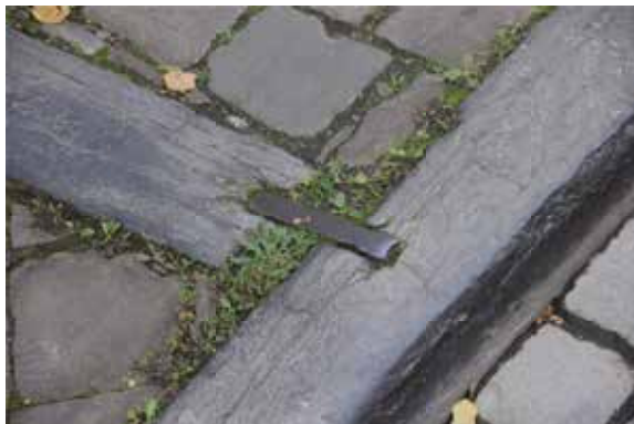
Fig. 25 Exemple d'agrafe en métal liaisonnant la bordure de trottoir rue du Lilas (T. Schlessler, 2019 © urban.brussels).
