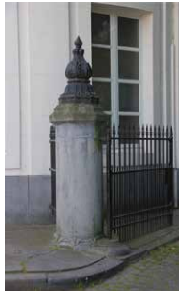
Fig. 11 Borne-grille située sur le trottoir longeant le Théâtre du Parc, rue de la Loi (© Thomas Schlessler, 2019).
