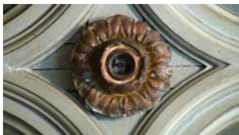
FIG. 6C Fleur en staff dissimulant un socket d'ampoule en porcelaine dans le couloir d'entrée (© MA2, 2015).
