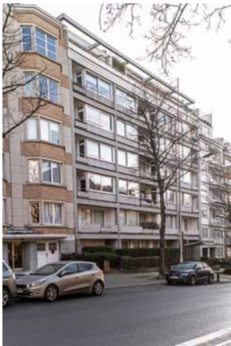
FIG. 6 Façade de l'immeuble à appartements Coghen (avenue Coghen 244, Uccle), sur demande de l'Immobilier Ruttiens, d'après les plans de Josse Franssen et réalisé par Henri Ruttiens (A. de Ville de Goyet, 2020 © urban.brussels).
