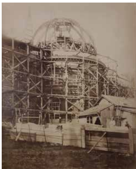
FIG. 9 Reconstruction de la coupole du château de Laeken après l'incendie de 1891 (10 mars 1892) (Archives du Palais royal © AGR, 661bis).
