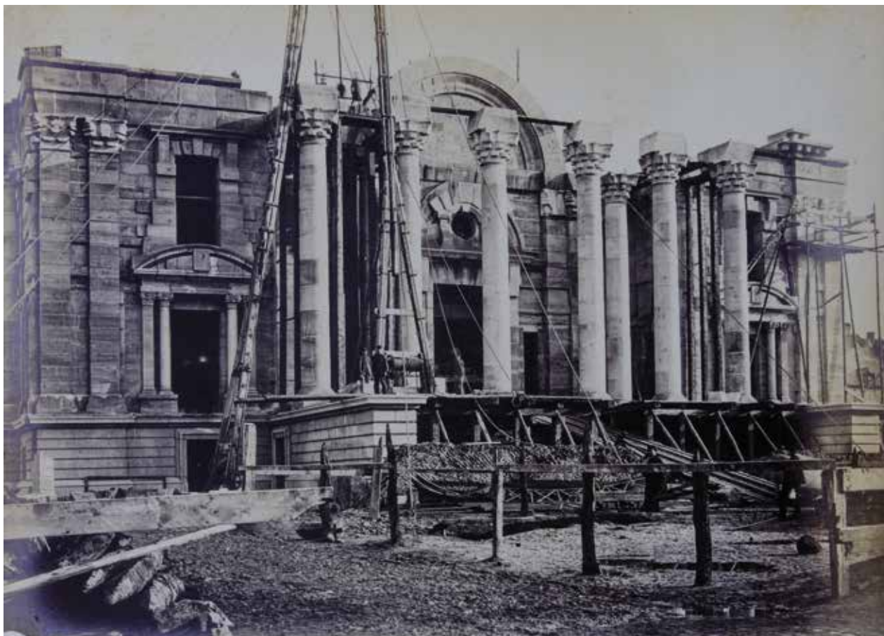
FIG. 24 La Bourse en construction ; la taille de l'ornementation n'a pas encore commencé. Photographie de Jean Théodore Kämpfe ( Bourse de Commerce de Bruxelles. Travaux de construction. Différentes vues du chantier, 1869-1870, © CIDEP).
