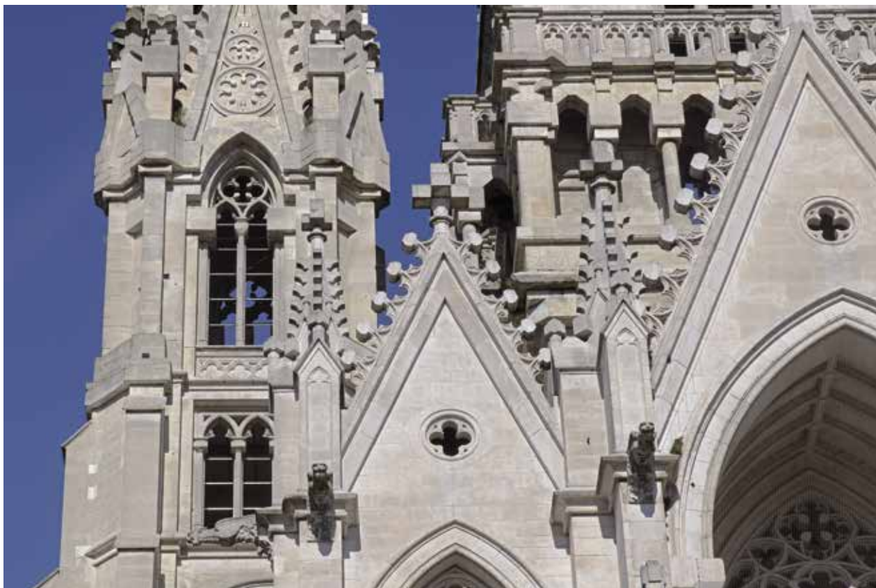
FIG. 3 Église Notre-Dame de Laeken ; des pierres devant servir à l'ornementation n'ont jamais été taillées (A. de Ville de Goyet, 2021 © urban.brussels).
