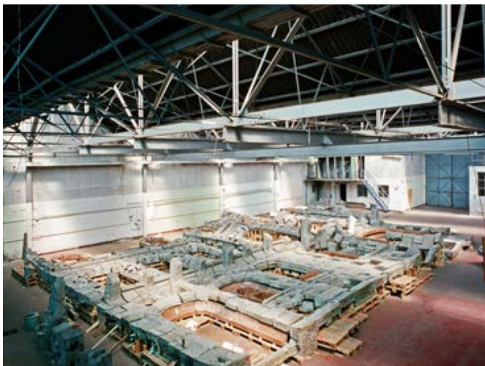
FIG. 2A Chantier de réassemblage de la façade de l'hôtel Aubecq en 2010, rue François-Joseph Navez 102 à Schaerbeek (M. Nouel © urban.brussels).
