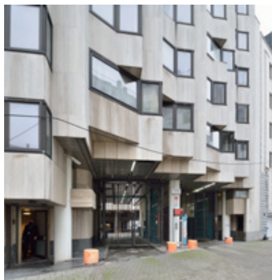
FIG. 7 Façade de l'immeuble à appartements pour la CGER (Wim Kenis © urban.brussels, 2021).
