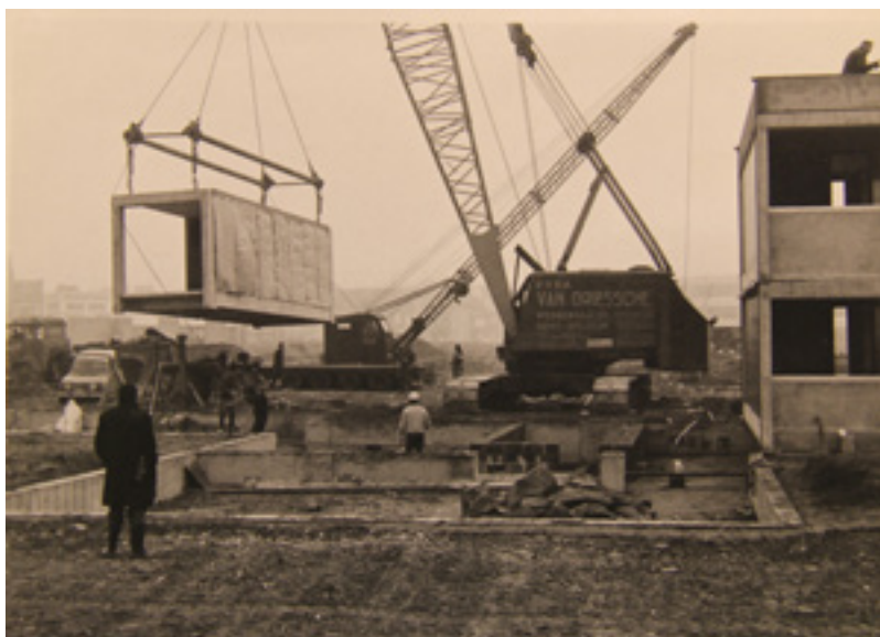
FIG. 4 Les modules Variel étaient préfabriqués dans une usine à Montsoult (France), avant d'être transportés vers le chantier d'Ixelles (© s.n., Archief Technische Dienst VUB, 1973).
