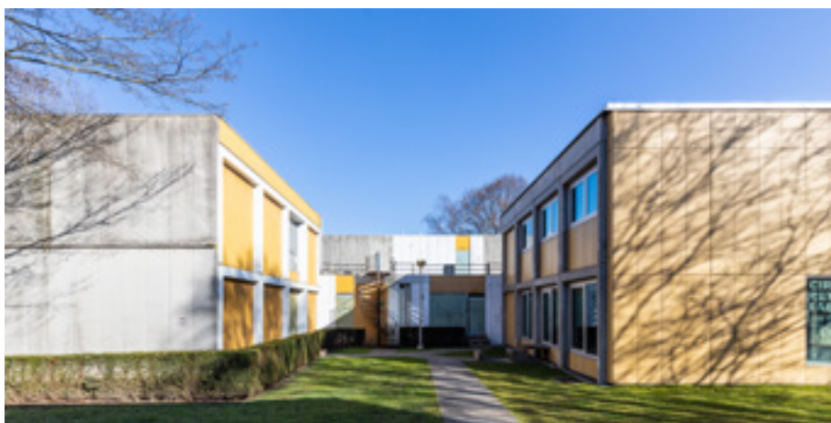
FIG. 7 Le Circular Retrofit Lab (à droite), qui a été mis en place en face du WVDM Living Lab (à gauche), est un projet pionnier dans le domaine de la rénovation durable et circulaire (Corentin Haubruge, 2019 © ORIGIN Architecture & Engineering).
