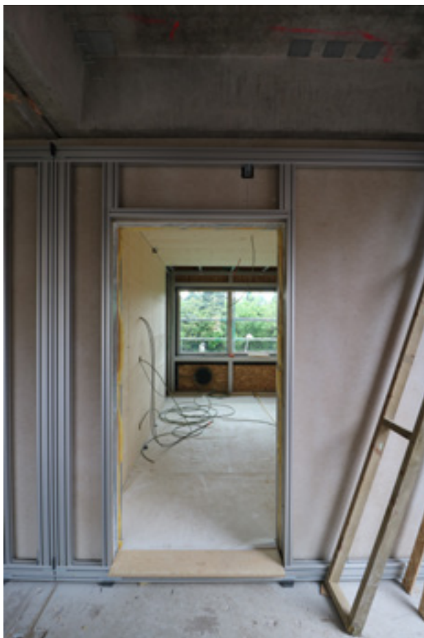
FIG. 19 Les profilés en aluminium permettent une structure murale diversifiée avec différentes couches et un (dé)montage facile. Ils ont donc été utilisés dans les trois stratégies de rénovation mises en œuvre (© MAKER architecten, 2024).
