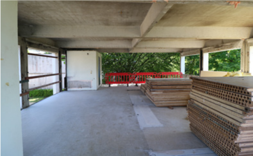
FIG. 21 Les cloisons intérieures des logements étudiants sont constituées de panneaux Fontex en bois compressé, d'une épaisseur de 5 cm et dotés de canaux verticaux creux internes (© Fontex, s.d.).
