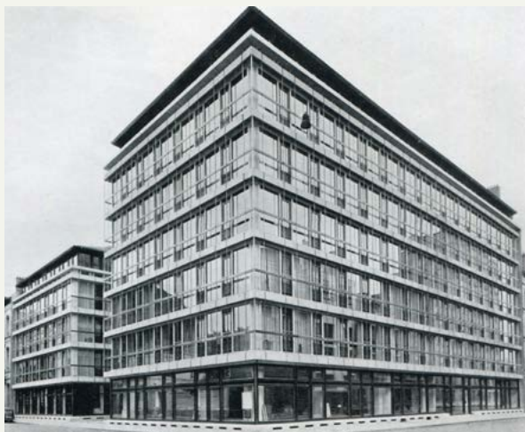
FIG. 6 L'immeuble Foncolin, arch. André Jacqmain, 1958 (Technique des Travaux, 1959, n° 34, p. 103).
