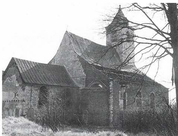
11. Côté nord de l'ancienne église en 1969 avant restauration (photo, collection R. VERBEKE / Comté de Jette).
