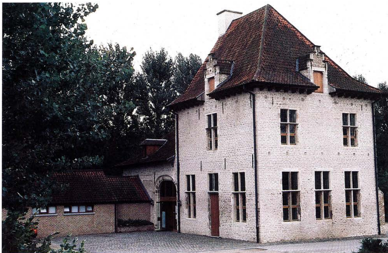
53. Vue du Slot restauré et du nouveau bâtiment annexe (photo Y. CABUY, 1992).
