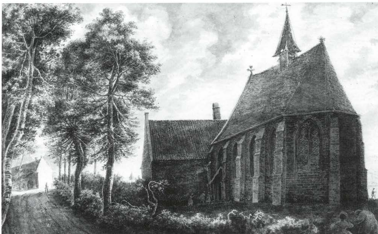
44. La chapelle Marie-la-Misérable avec, à l'arrière-plan à gauche, une partie de l' hof ten Groenenberg , démolie vers 1850 (dessin P. VITZTHUMB, 1831 © Bibliothèque royale, Cabinet des Estampes).
