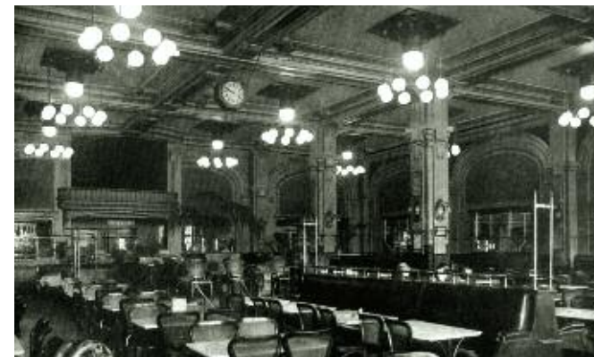
Le café du Palace Hôtel , place Rogier à Bruxelles. Adhémar Lener et Antoine Pompe architectes, 1904-1908.
