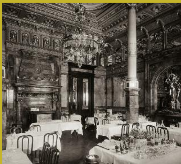
Ancienne salle de restaurant de l'hôtel. Alban Chambon décorateur, 1894.
