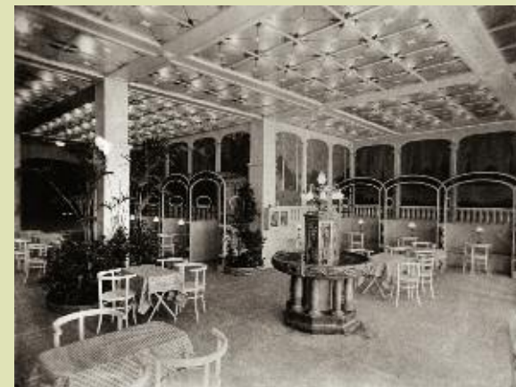
Foyer du Pathé Palace, 85 boulevard Anspach à Bruxelles. Paul Hamesse & Frères architectes, 1913.
