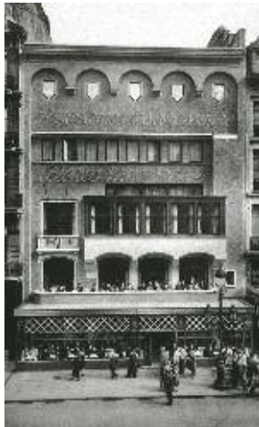
Aux Armes des Brasseurs , 56-58 boulevard Anspach à Bruxelles. Adrien et Yvan Blomme architectes, 1939.
