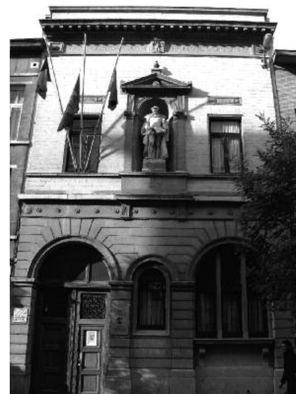
École primaire n° 7, rue Haute, par l'architecte Adolphe Samijn.
