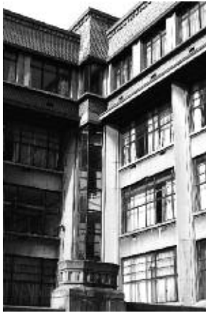
Athénée royal de Koekelberg: mélange de pierre, de briques et châssis en acier des façades latérales.
