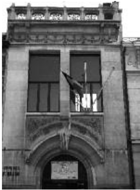
Façade à rue avec corniche ouvragée de l'antenne de l'athénée Fernand Blum.
