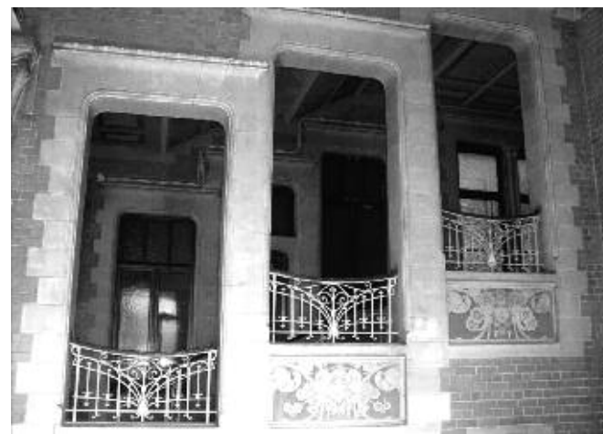
Balustrades et trumeaux des baies de la cage d'escalier.
