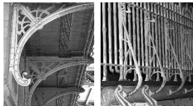
Consoles de support de la galerie du préau.
