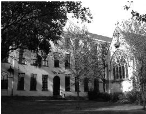
Bâtiments de l'école primaire.
