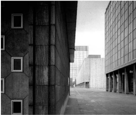
Détail de la composition du revêtement en pierre bleue du mur extérieur, avec des fenêtres carrées, sous l'arcade sud de l'aile Esplanade.
