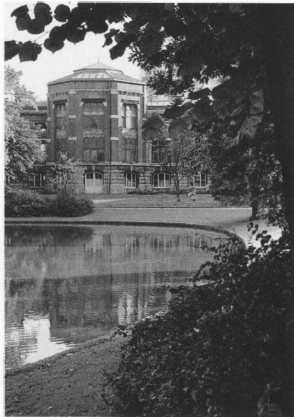
La silhouette austère de l'Institut d'Anatomie ferme le paysage en direction d'Etterbeek. Le fer et le verre, en façade, expriment sans détour la vocation scientifique et moderne du bâtiment (vue actuelle).
