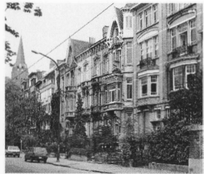
Avenue des Éperons d'Or. Maisons de style éclectique créées par les frères Delune (nos 3 à 14 à l'exception des deux immeubles modernes).
