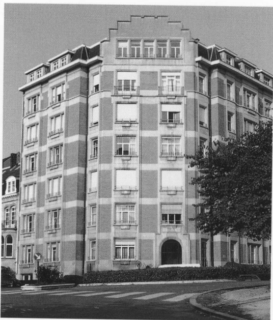
Avenue des Klauwaerts, no 38, à l'angle de l'avenue Géo Bernier. Immeuble de l'architecte Paul Hamesse, associé à ses frères Georges et Léon. La rigueur de la composition et les fers forgés appartiennent à l'esprit Art Déco.
