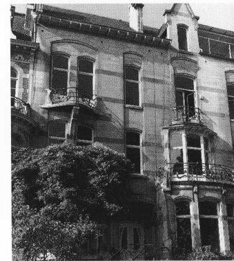
A gauche : Détail de la maison personnelle d'E. Blérot, située alors au coin de l'avenue de la Cascade et de la rue Vilain XIII, et démolie en 1965. Planche de l'Emulation.
