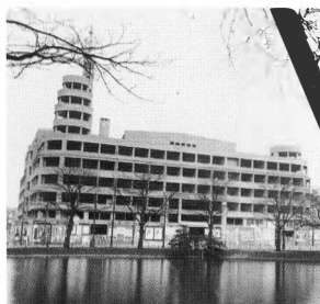
L'immeuble de l'LN.R. en construction, vers 1937.
