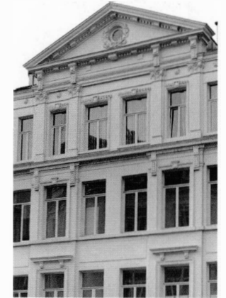
L'immeuble d'angle formant le coin de la rue de l'Enseignement et de la rue Royale s'orne d'un fronton.
