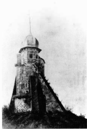
La tour hydraulique près de la porte de Louvain alimentait en eau le haut de la ville.
