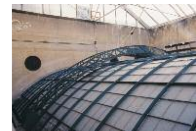
Pont roulant commandé dès 1916 par l'architecte pour permettre le nettoyage du lanterneau.
