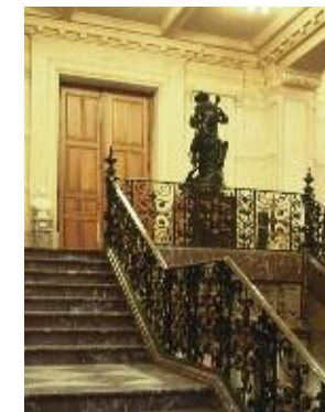
Escalier d'honneur vers la salle des Pas perdus du premier hôtel communal. Au sommet de l'escalier se dresse une statue colossale en plâtre.
