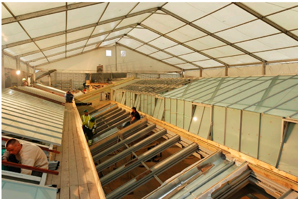
La rénovation de la toiture en cours. (© Barbara Van der Wee architects, 2022 et © Bozar Archives)
